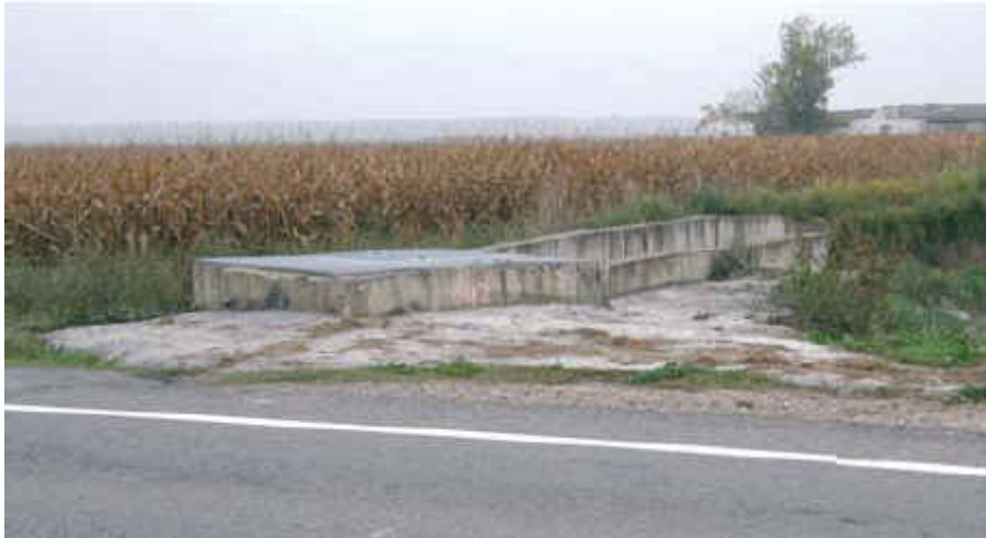
Aplicación de hormigón en una intersección de acequia con carretera
