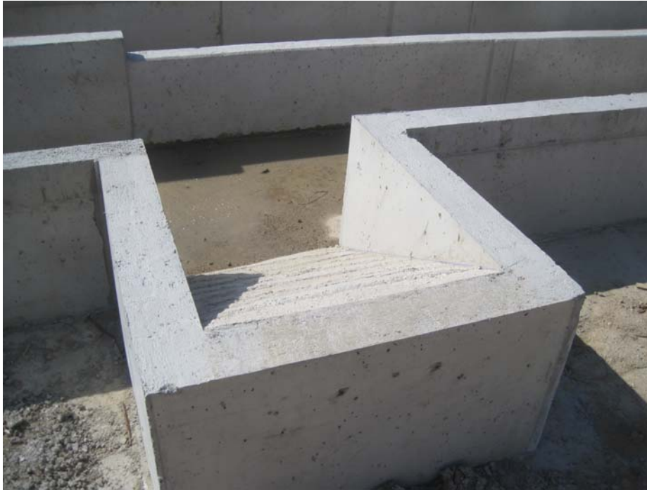
Rampa de salida para la fauna en el cauce general del sector XXII-Arga3
