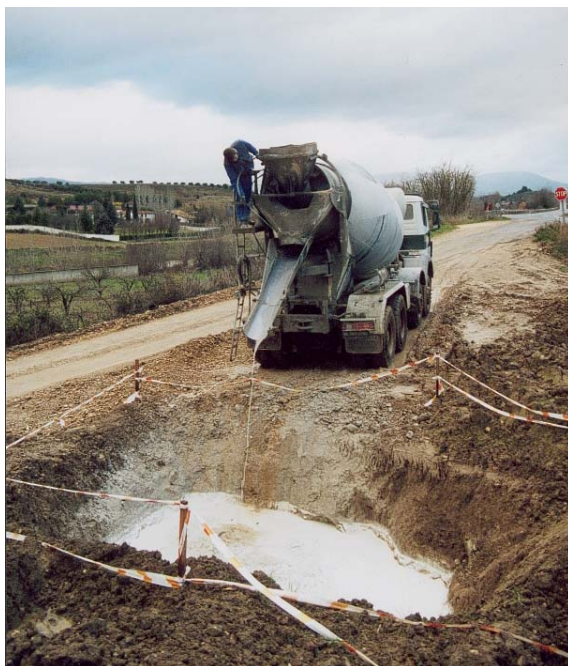
Punto de limpieza de cubas de hormigón
