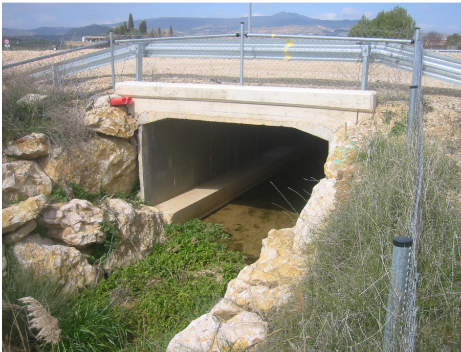
Paso adaptado para visón en la carretera NA-122 (Allo)
