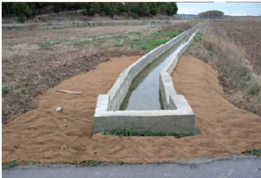
Colocación de geotextil antihierbas en una intersección
