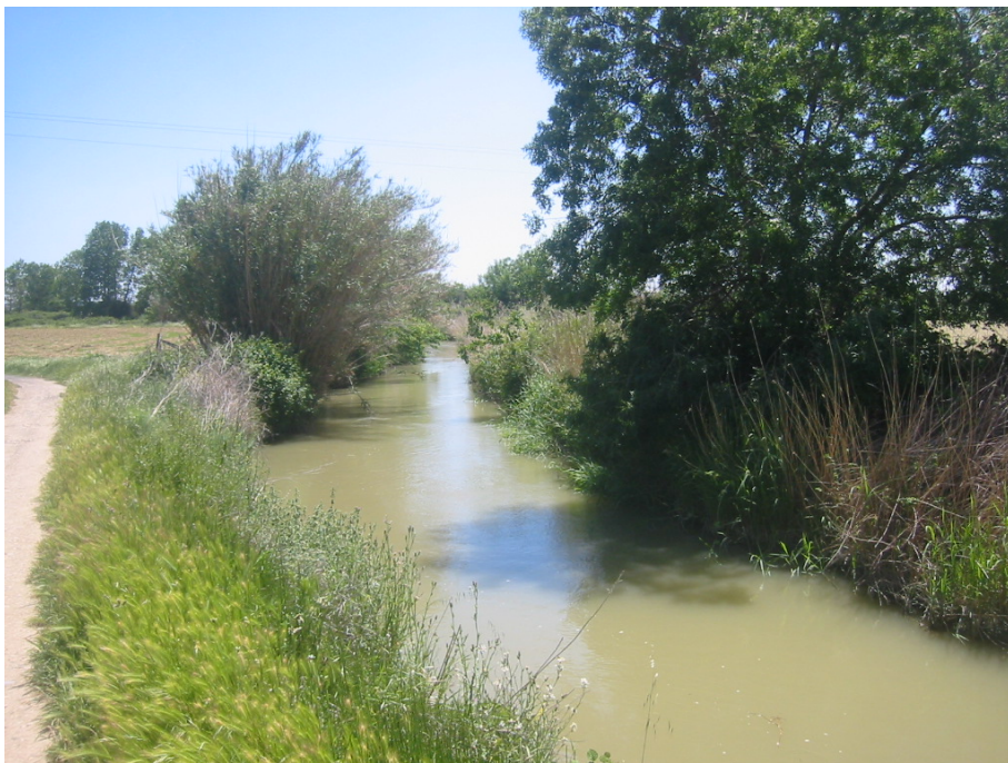
Tramo final de la acequia Bayunga
