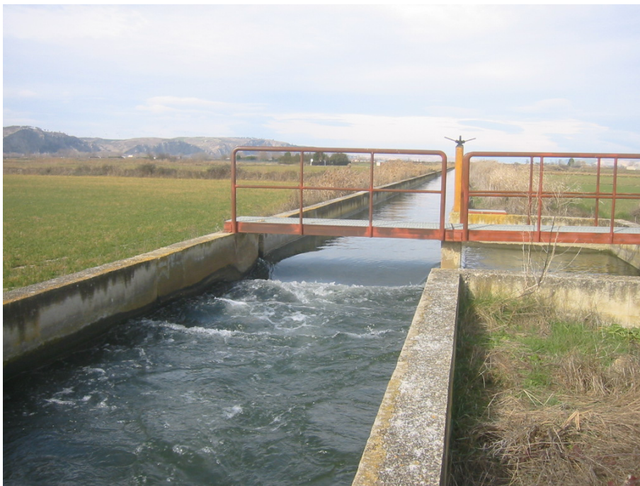
Cauce revestido de la acequia Río Arlas
