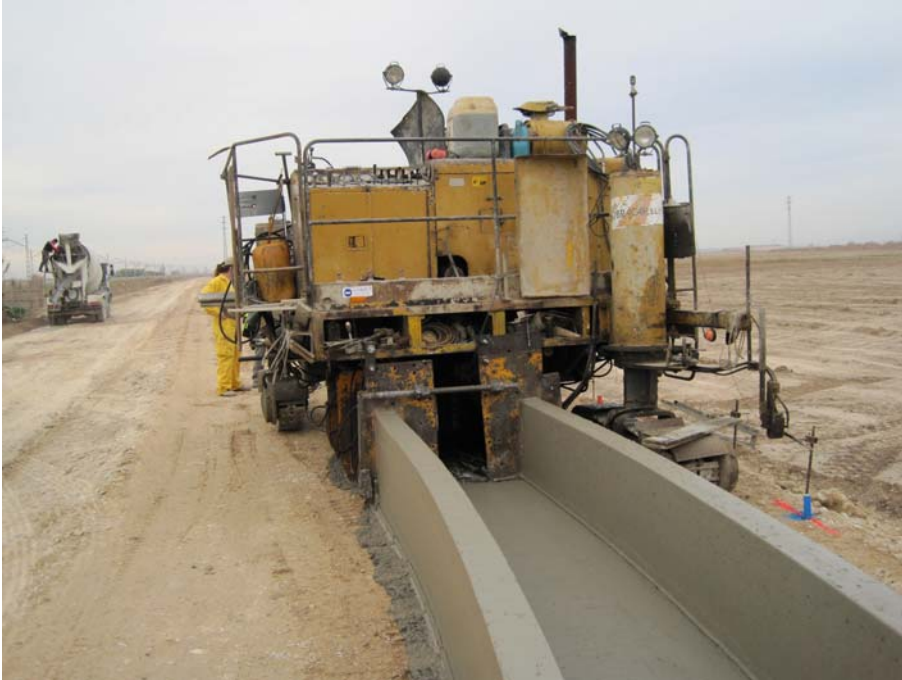
Construcción de acequia mediante extendedora
