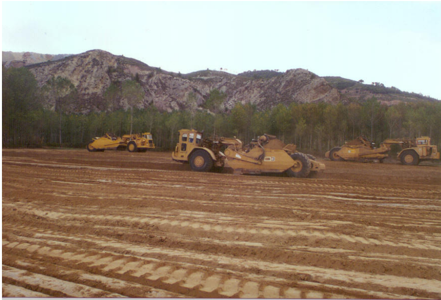
Mototraíllas efectuando labores de capaceo
