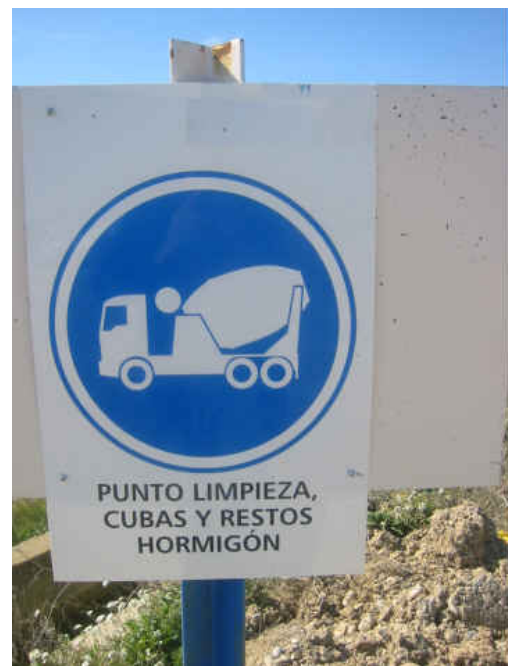
Punto de limpieza de cubas de hormigón
