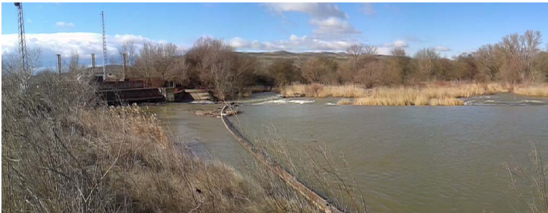
Presa del Arquillo y toma en el río Arga (Falces)
