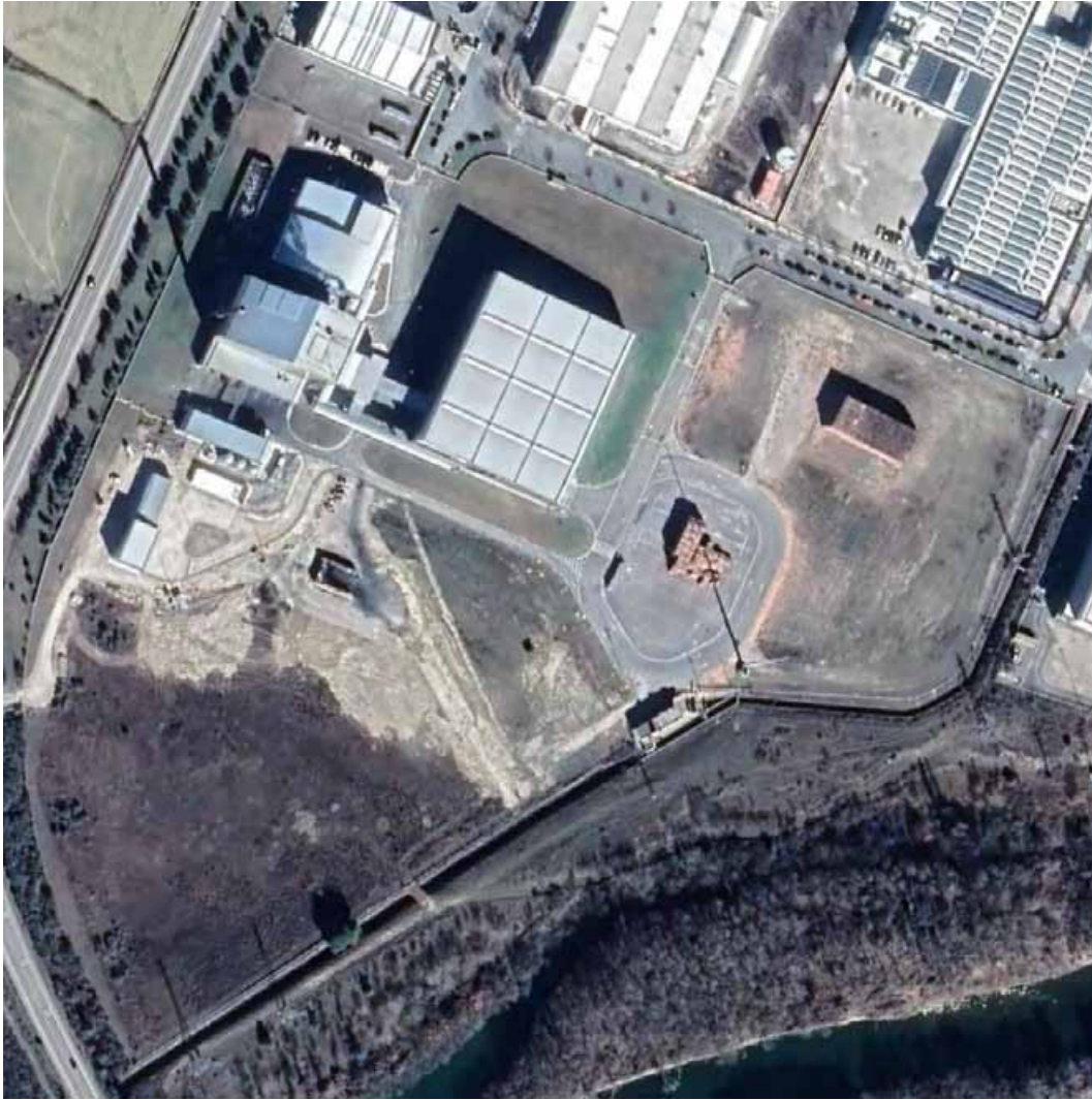
Graf 5. Planta de biomasa de Sanguesa, con 11.388 m2 construidos sobre parcela de 10,8 Has, segunda mayor instalación de la muestra analizada por superficie construida (en el caso de la primera no es posible desagregar la superficie de esta actividad de otras que coexisten en la parcela con carácter muy diferente).
