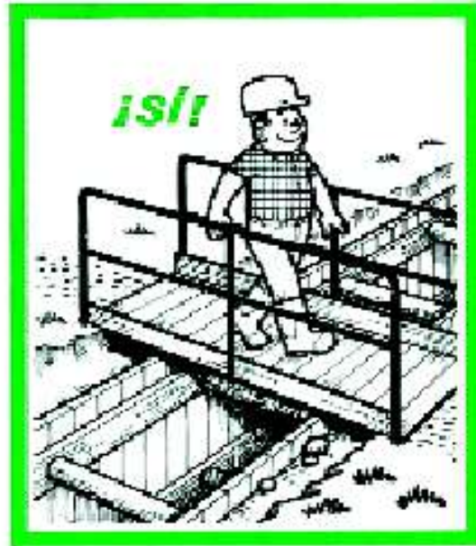
Se deben instalar pasarelas provistas de barandillas para franquear las zanjas.
