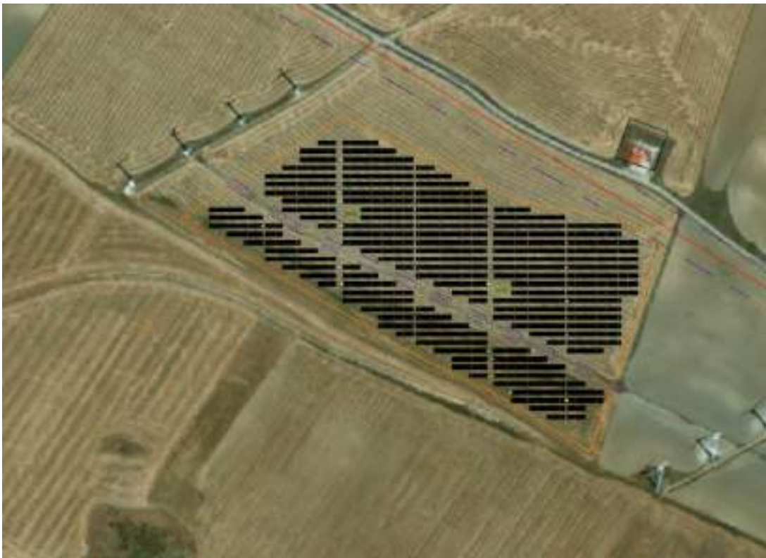
Imagen 1. Vista aérea de la ubicación.
