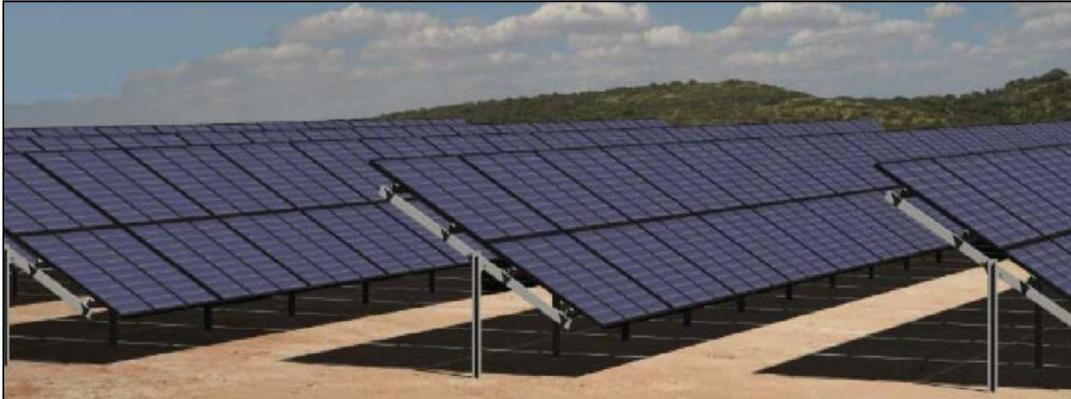
El sistema de montaje permitirá un fácil montaje y desmontaje de los módulos fotovoltaicos, así como un fácil mantenimiento y limpieza de los mismos.
