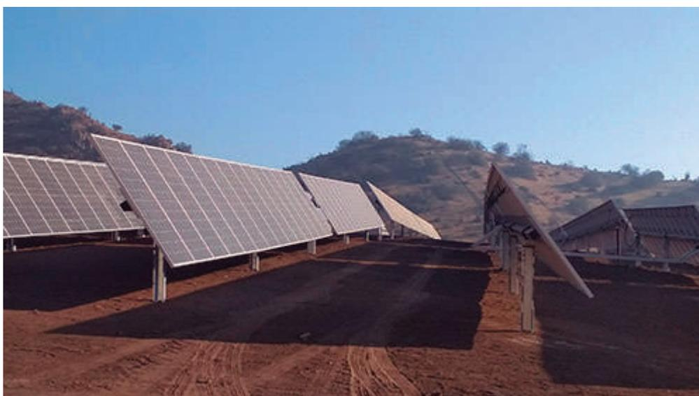
El seguidor solar tiene un rango de giro de  $\pm 55^\circ$  y se adapta a terrenos con pendientes cambiantes y contornos irregulares.
