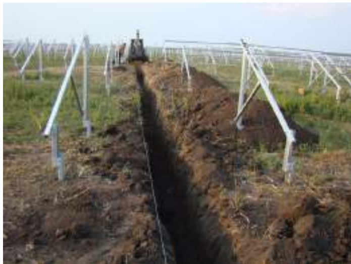
Imagen 17. Tendido de cable en zanja
