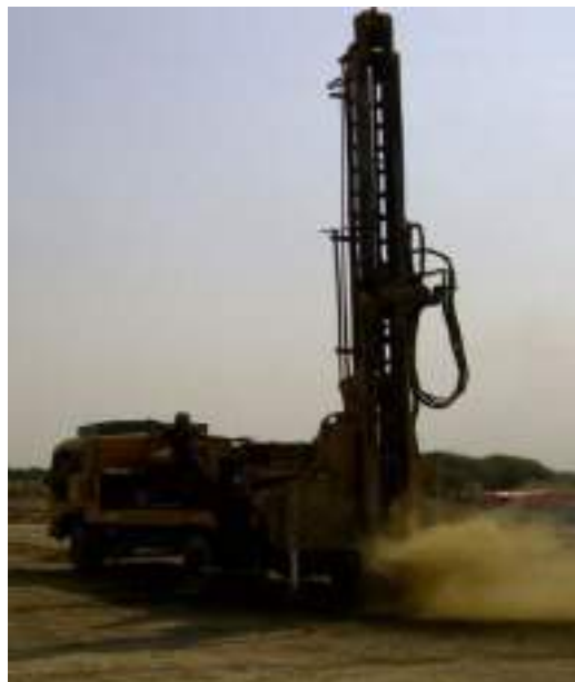
Imagen 14. Hincado de perfiles con maquinaria especializada
