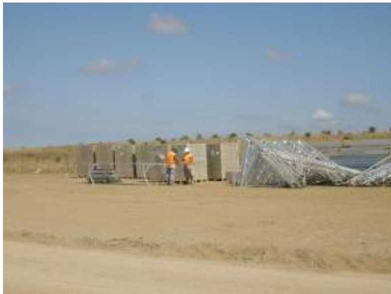
Imagen 8. Fotografía de instalaciones provisionales
