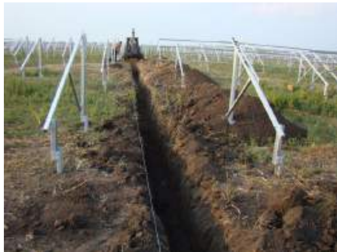
Imagen 17. Tendido de cable en zanja
