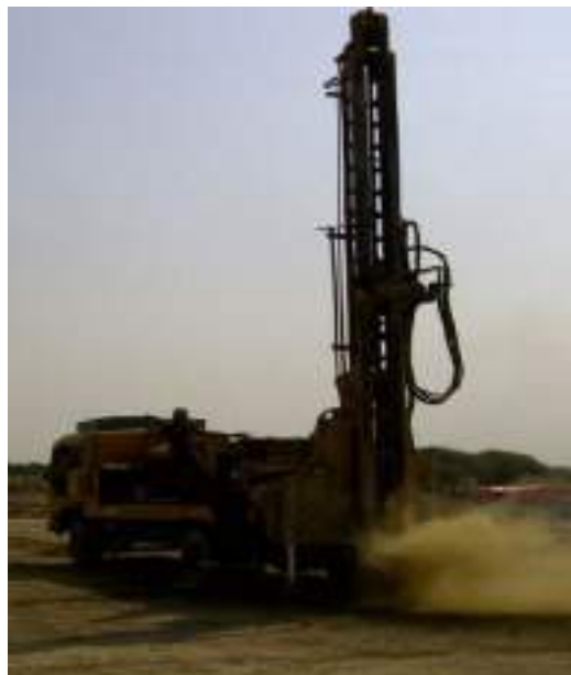
Imagen 14. Hincado de perfiles con maquinaria especializada
