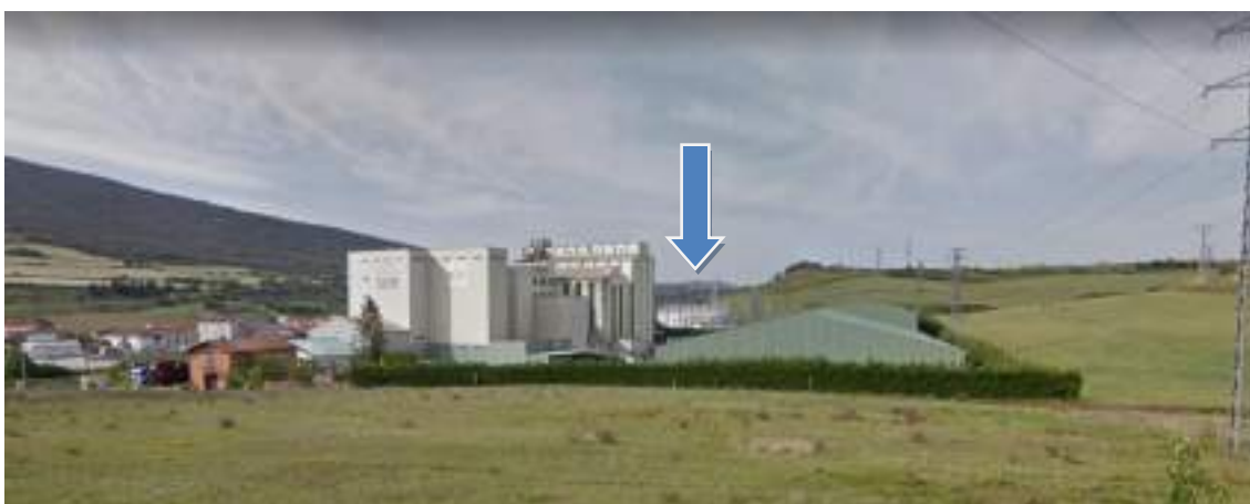
Imagen 8.- Subestación existente. Fuente Google Maps.
