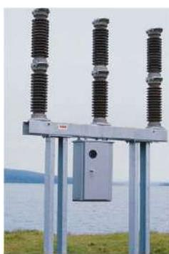
**Figura X. Interruptor automático**
