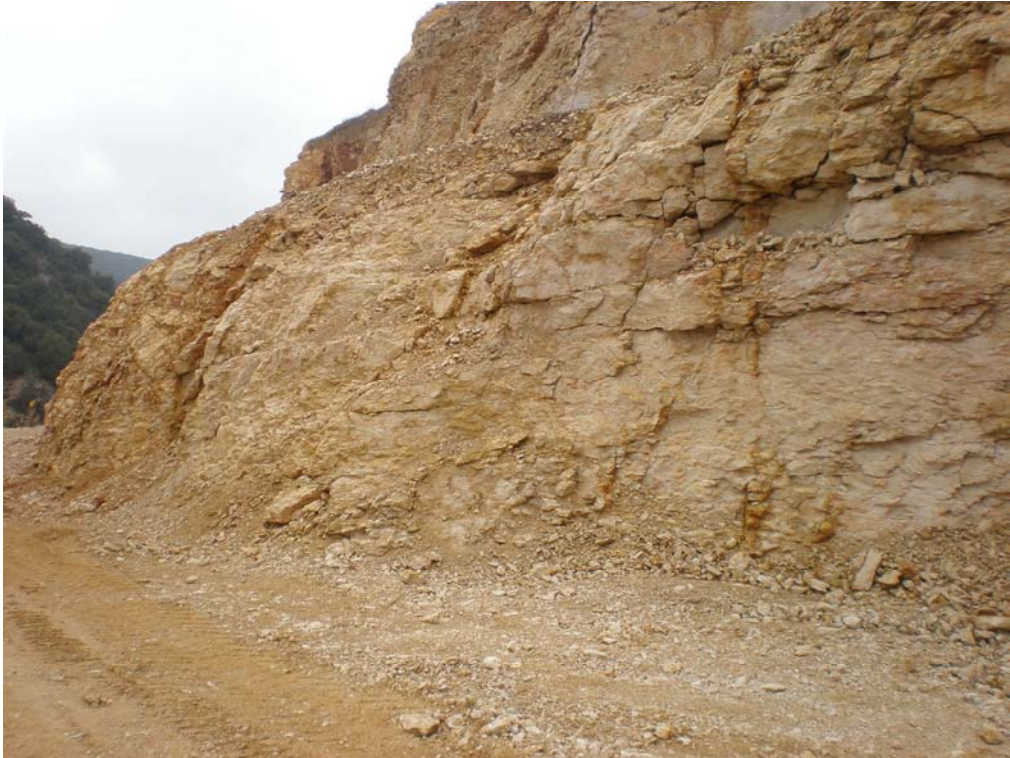
Fotografía 5.- Vista del talud en la estación T6, en donde se observa el material menos cuarteado. Se diferencia una familia de fracturas subhorizontales (interpretadas como posible estratificación), cortada por fracturas subverticales.
