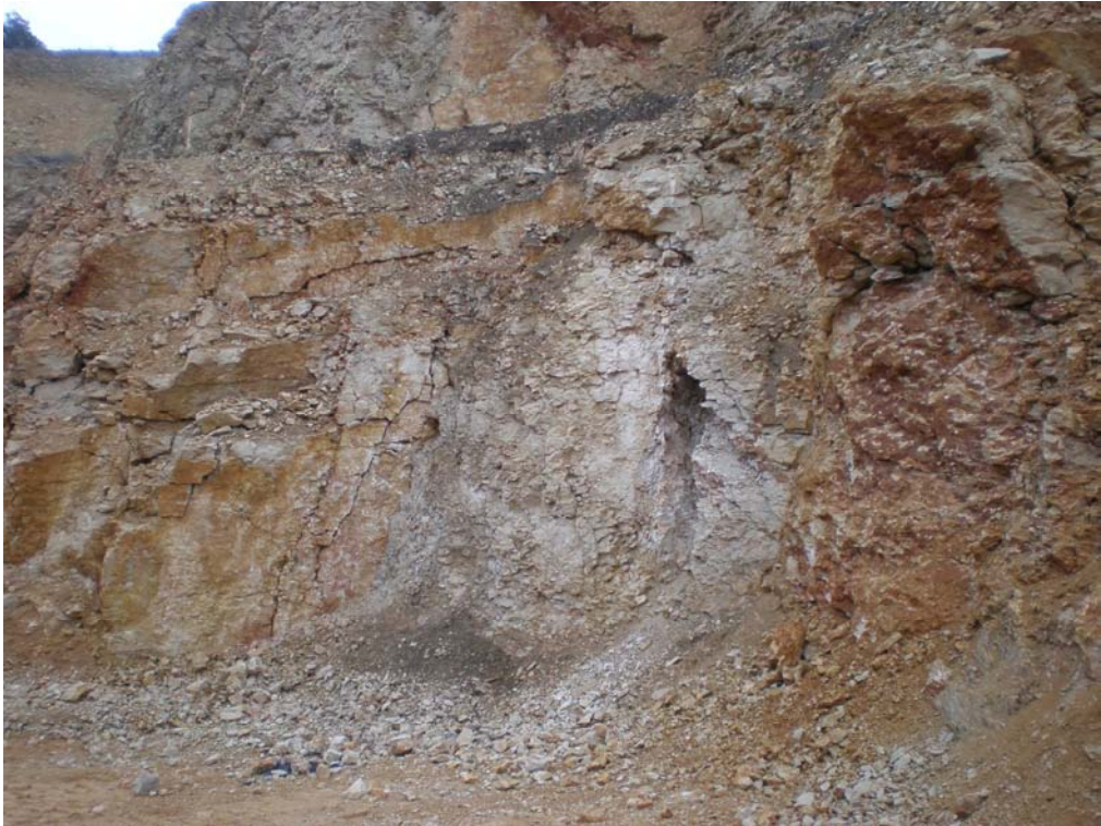
Fotografía 3.- Vista de una parte del talud en la estación T3, donde se observa el gran estado de fracturación de la roca. Los colores más rojizos corresponden a zonas de mayor contenido en arenas.
