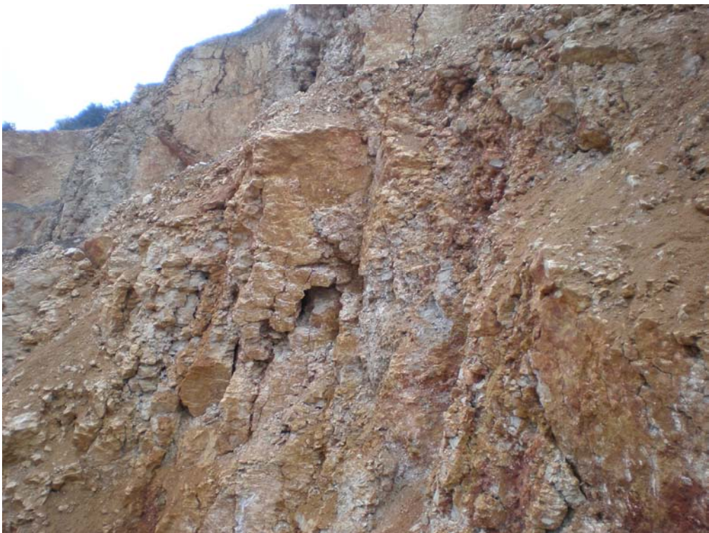
Fotografía 4.- Imagen tomada en la estación T4, en el que se observan grietas de apertura importante que delimitan bloques en posible estado metaestable.
