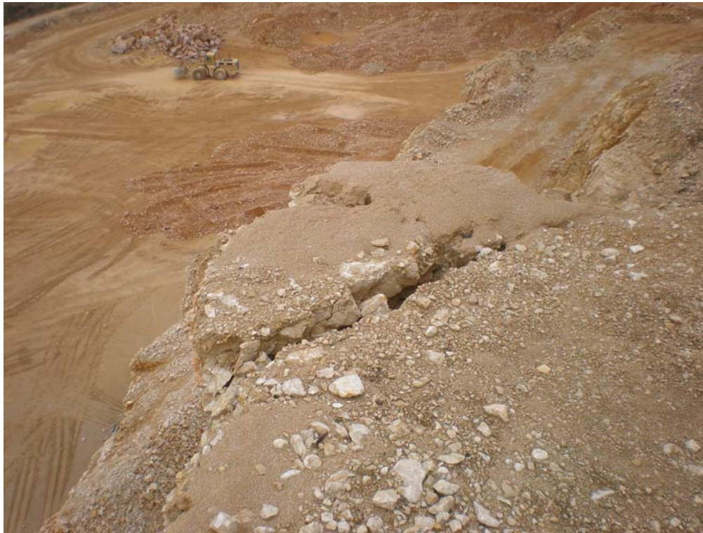
Fotografía 7.- Tomada en la berma de la estación T11, se observa un bloque separado del resto de la berma, correspondiente a material metaestable del talud inferior.
