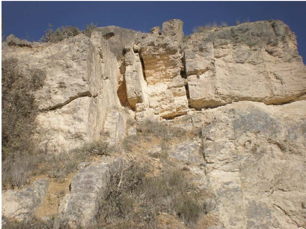
Fotografía 13.- Vista en la que se observa la gran apertura existente en algunas fracturas verticales que afectan a la roca. Vista desde el Este. Estación T16.
