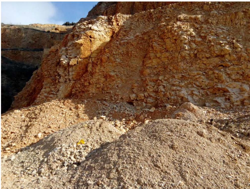
Fotografía 17.- Vista general del talud en donde se define la estación T22. Al igual que en la fotografía anterior, el material aparece muy fracturado. Se observa a la izquierda de la imagen un plano de fractura muy claro en posición subvertical.
