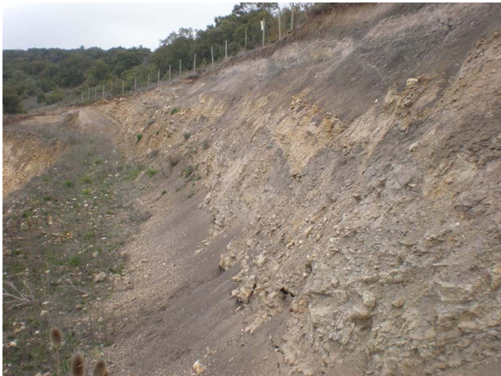
Fotografía 8.- Aspecto de la berma y el talud superior, límite de NE de la explotación, con los materiales buzando aparentemente hacia el interior del macizo.
