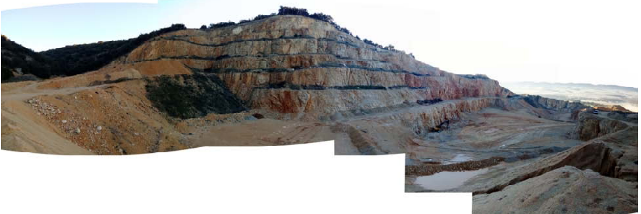
Fotografía 2.- Vistas generales del talud de restauración en el momento de realización de la presente actualización del informe inicial. Año 2019.
