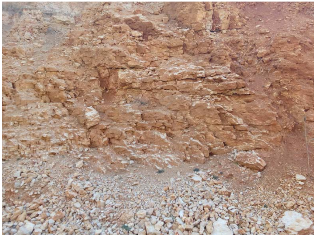
Fotografía 16.- Vista general del talud en donde se define la estación T21. Se observa la elevada fracturación del material. La estratificación se observa clara, aparentemente subhorizontal, aunque se dispone buzando 22°.
