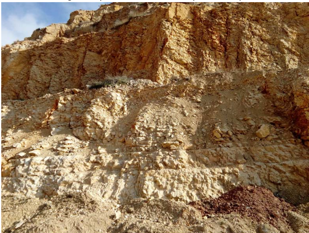
Fotografía 18.- Vista general del talud en donde se define la estación T23. Se observa la estratificación poco inclinada, y el elevado estado de fracturación del material. La berma que se intuye a mitad de imagen corresponde a la cota 592.
