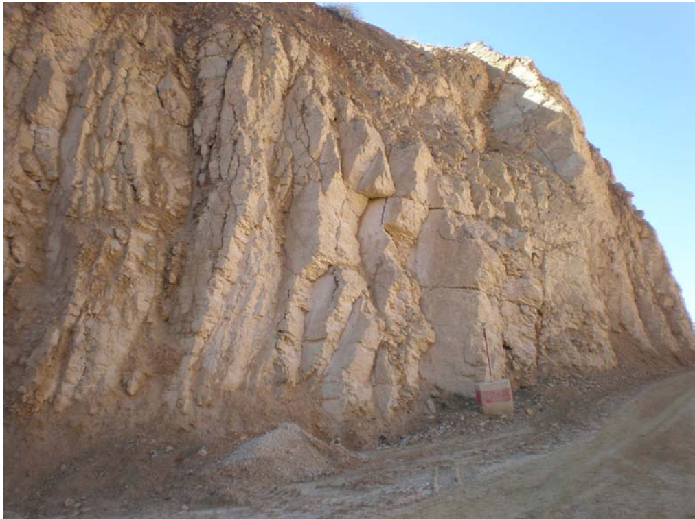
Fotografía 14.- Vista del talud en la zona de levantamiento de la estación T18. Se observa la estratificación y una serie de fracturas paralelas que cortan a la anterior, que aparecen buzando de forma importante hacia la izquierda de la imagen.
