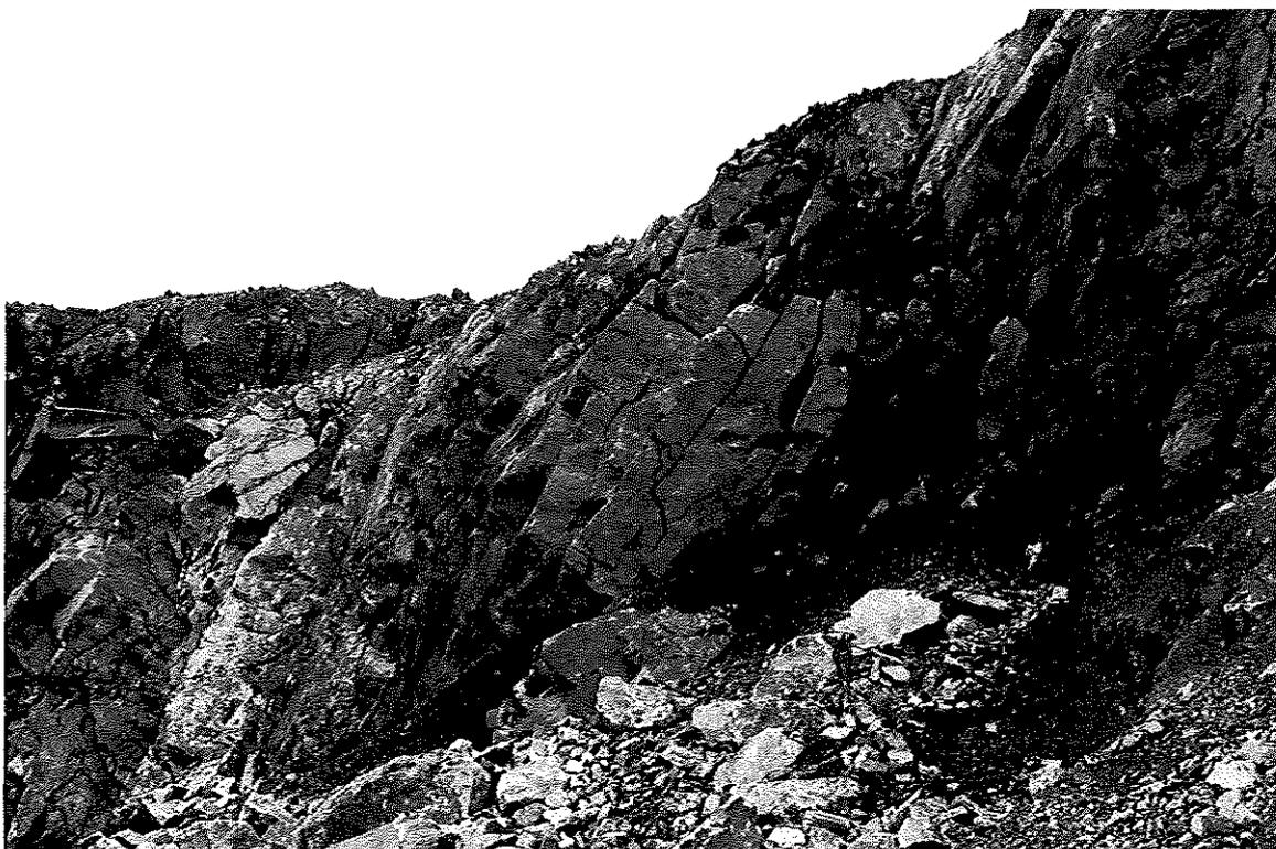
*Arriturri. Juntas del tipo  $J_2$  afectando al talud T2 (banco inferior).*
