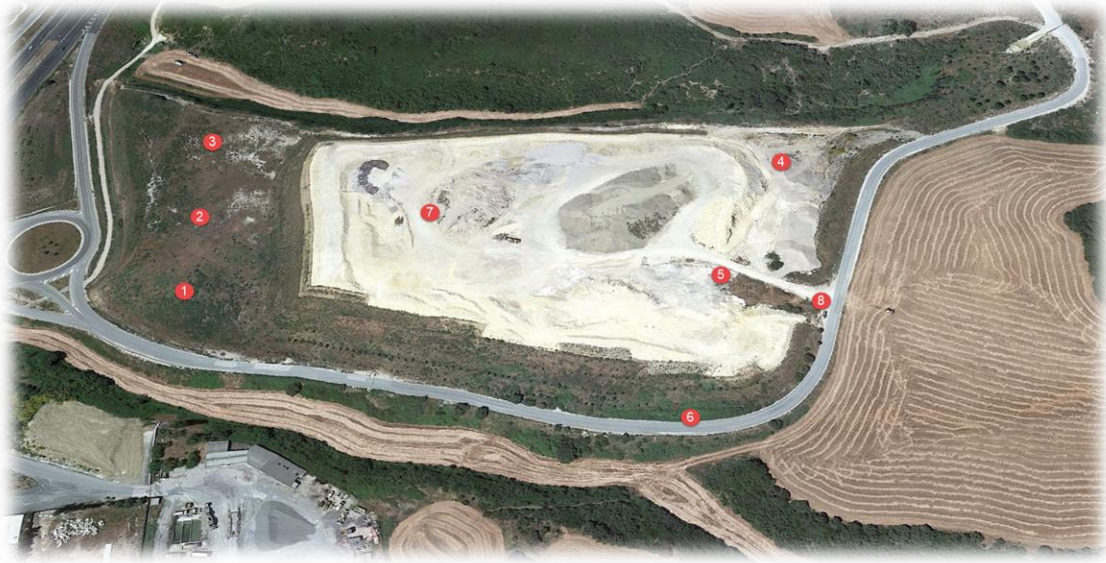
Figura 4.1.- Situación de las perforaciones dadas para el reconocimiento del cimiento en el emplazamiento de la escombrera.
