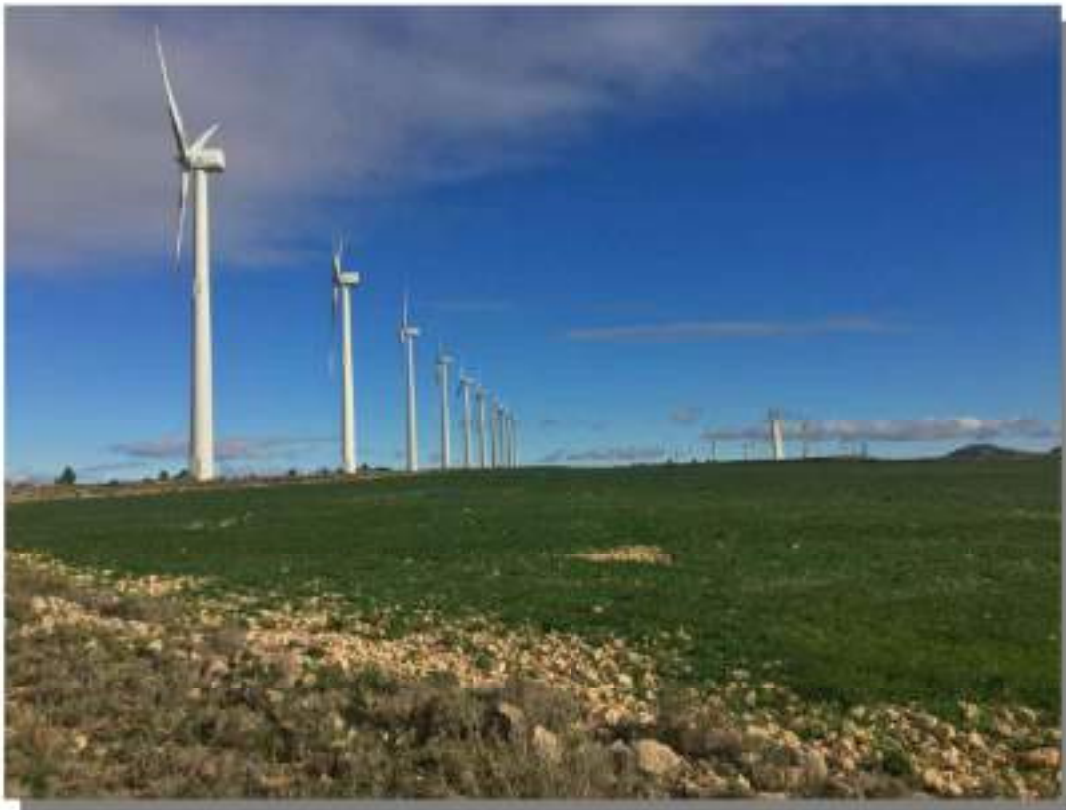
ACTUAL PARQUE EÓLICO SAN GREGORIO
