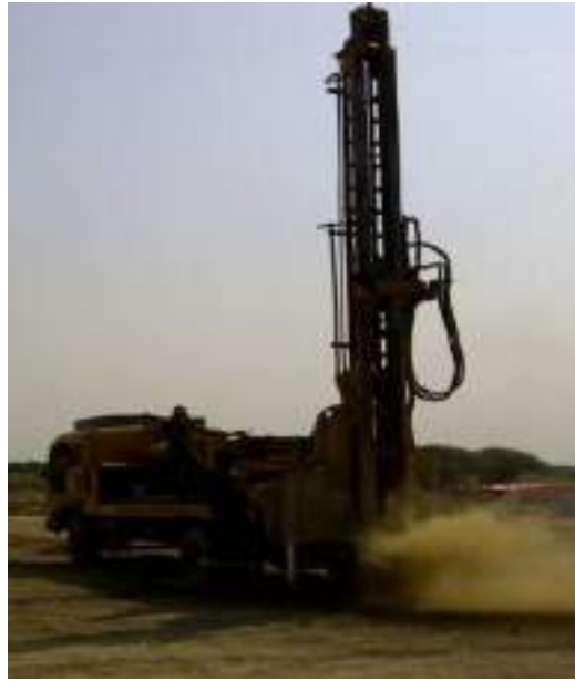
Imagen 14. Hincado de perfiles con maquinaria especializada
