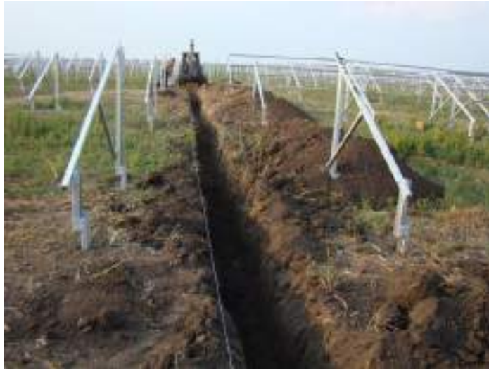
Imagen 17. Tendido de cable en zanja
