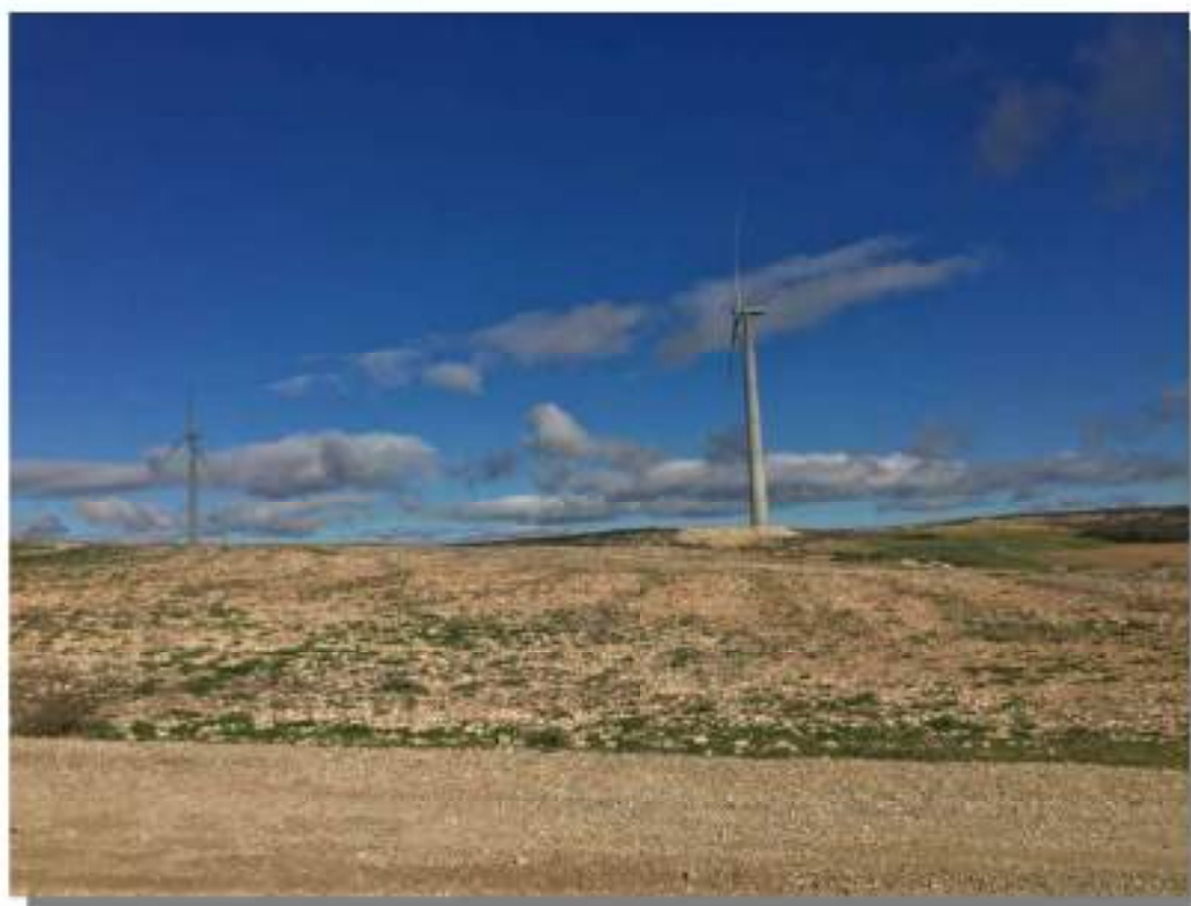
CAMPA DE ACOPIO Y AEROGENERADOR 10 SN (CONSTRUIDO), AL FONDO
