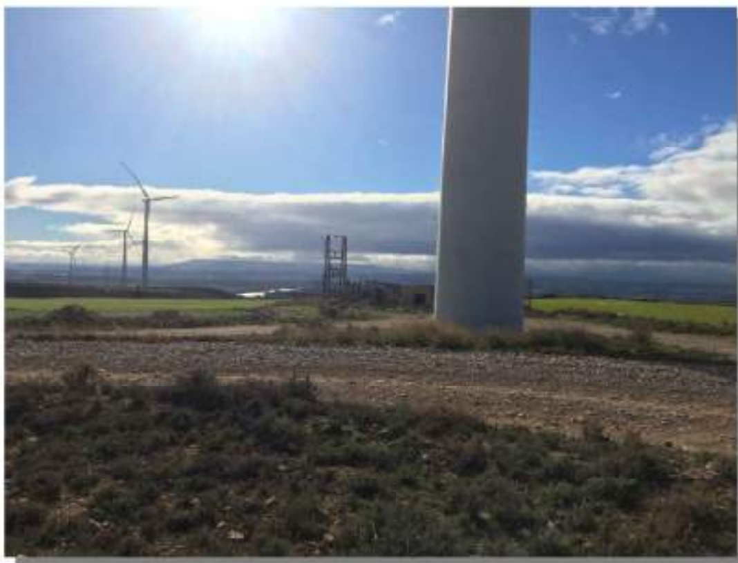
CAMINOS DE ACCESO A LA SET
