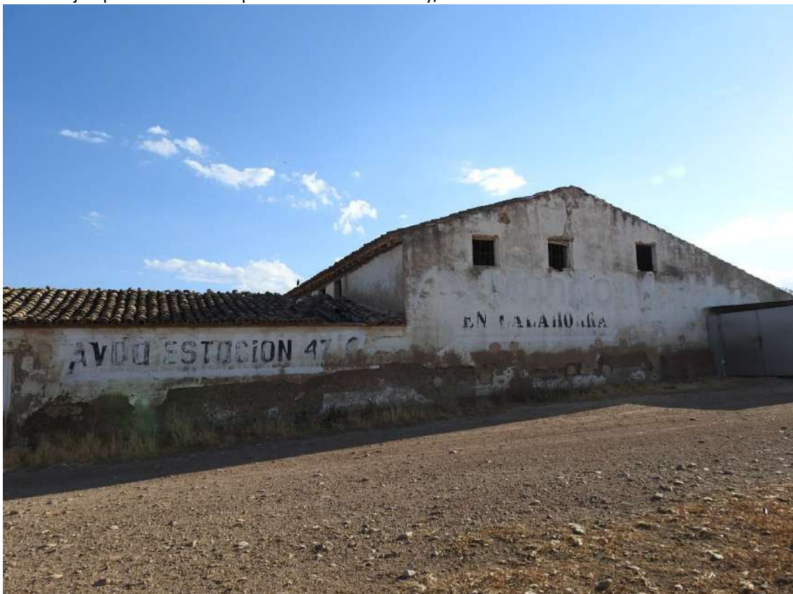
Fotografía 11. Construcción agro-ganadera junto a la carretera NA-115. No se detectó la presencia de quirópteros, aunque no es descartable su uso por alguna especie.
