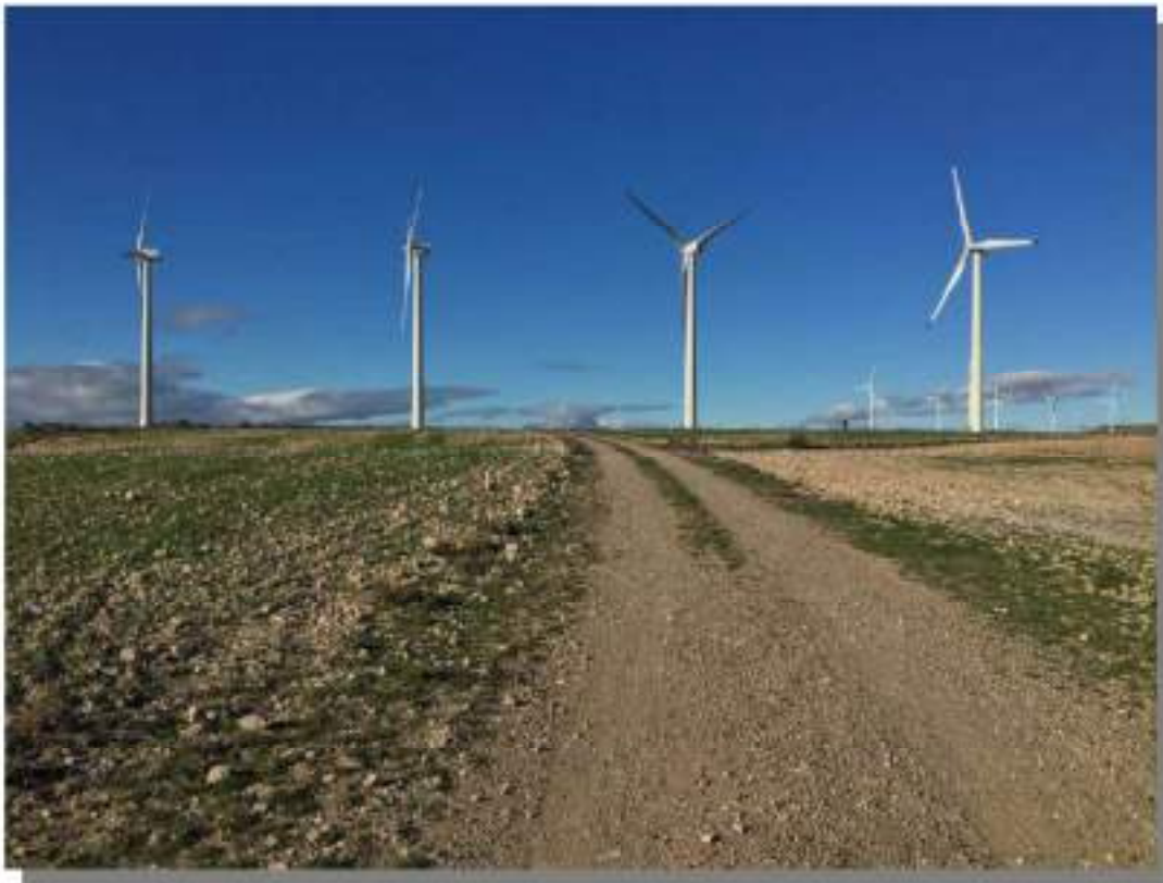
CAMINO HACIA LA UBICACIÓN DEL AEROGENERADOR BA-03
