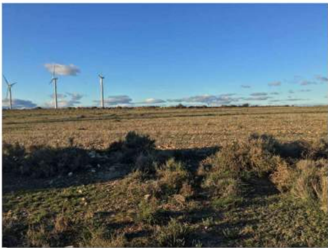
TRAZADO DEL NUEVO CAMINO DE ACCESO AL AEROGENERADOR BA-02 Y UBICACIÓN DE ESTE AL FONDO
