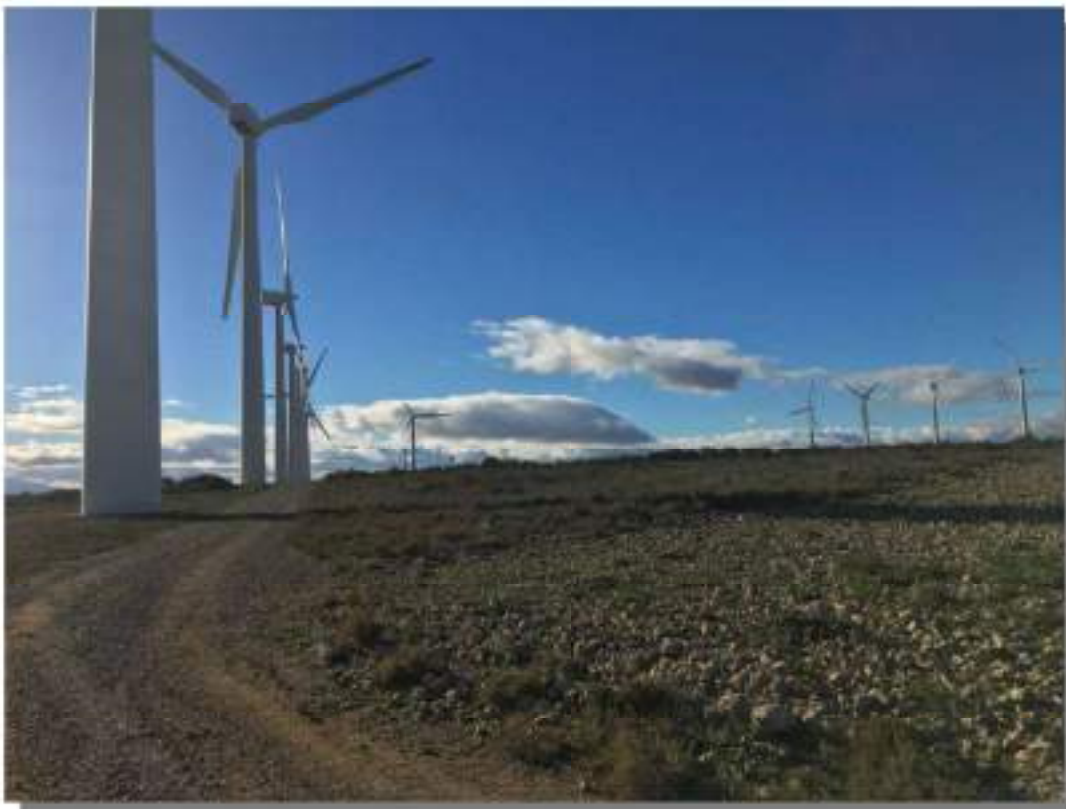
CAMINO EXISTENTE, DESDE DE LA UBICACIÓN DEL AEROGENERADOR BA-04
