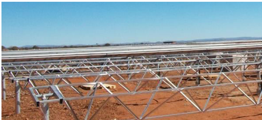
Imagen 15. Montaje de estructura solar con perfiles hincados directamente en el terreno
