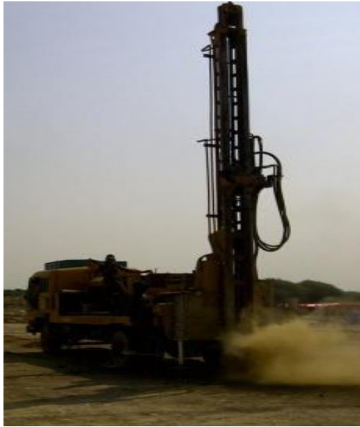
Imagen 13. Hincado de perfiles con maquinaria especializada
