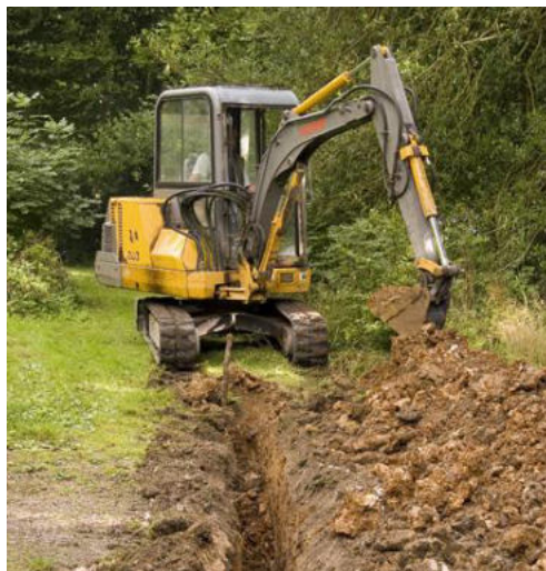
Imagen 14. Excavación de zanjas
