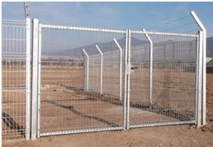
Imagen 12. Detalle de portón de dos hojas batientes tipo Acmafor
