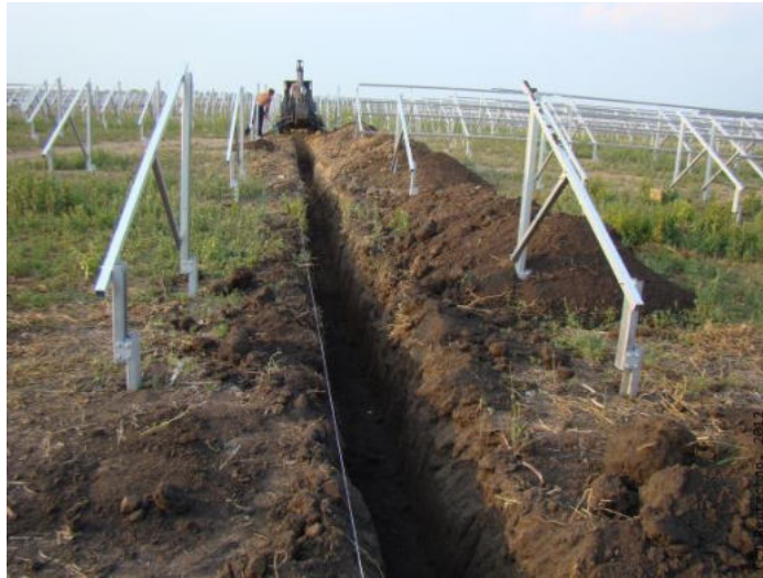
Imagen 16. Tendido de cable en zanja
