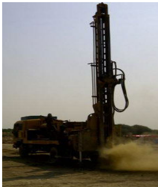
Imagen 14. Hincado de perfiles con maquinaria especializada
