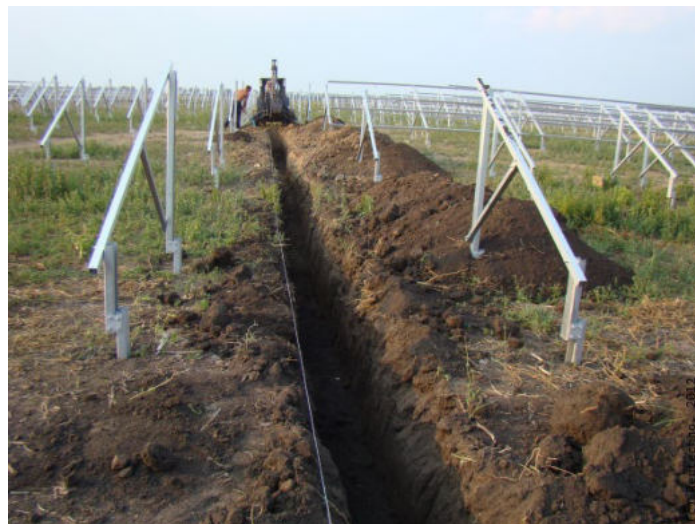
Imagen 17. Tendido de cable en zanja
