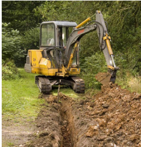
Imagen 15. Excavación de zanjas
