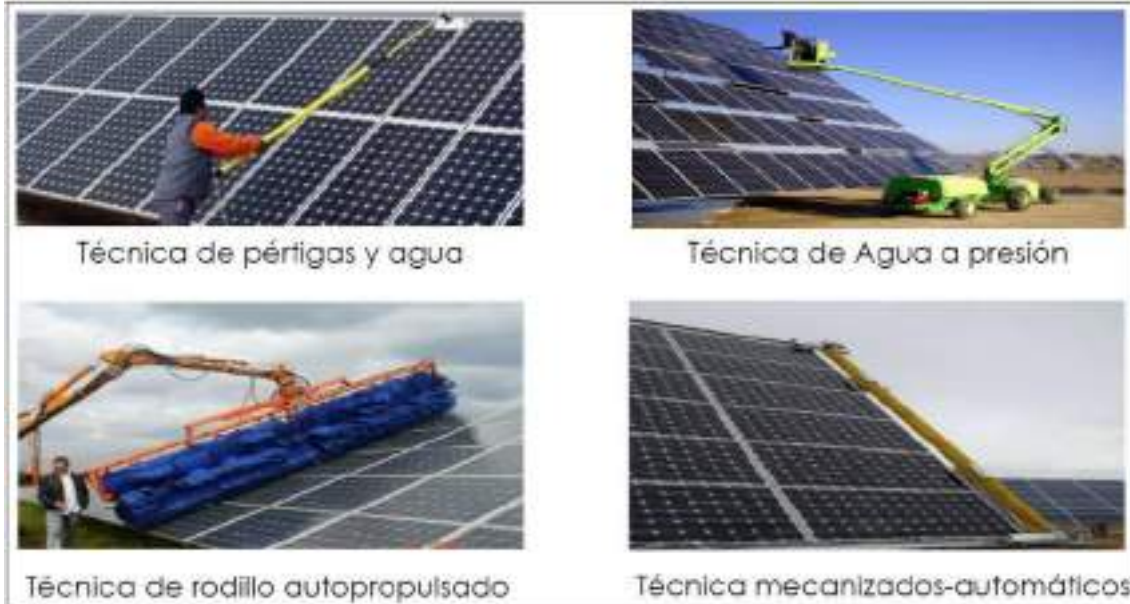
Imagen 2. Diferentes sistemas de limpieza de paneles solares
