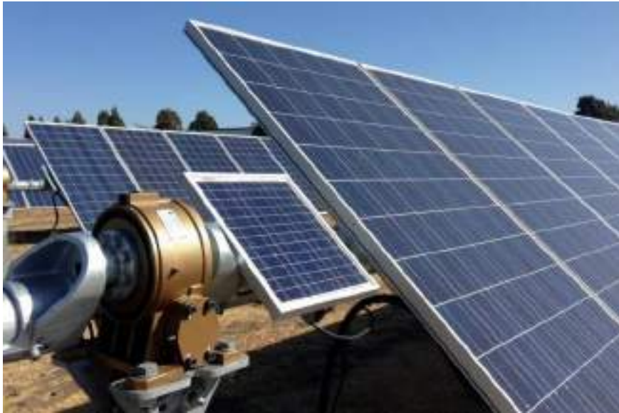
Imagen 3. Motor autoalimentado mediante placa fotovoltaica y batería
