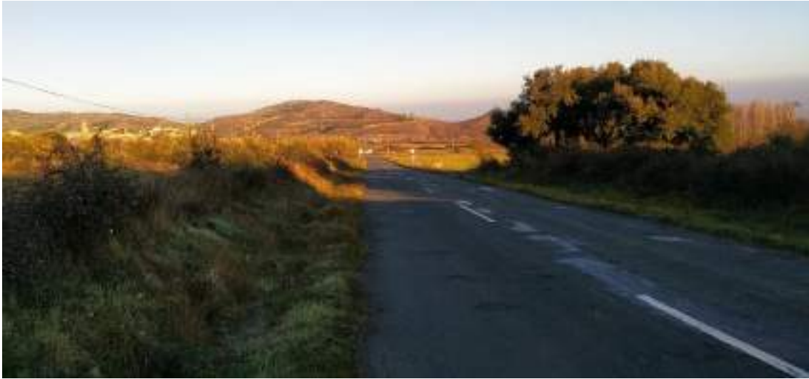
Fotografía 14. Carretera existente en el entorno del proyecto.
