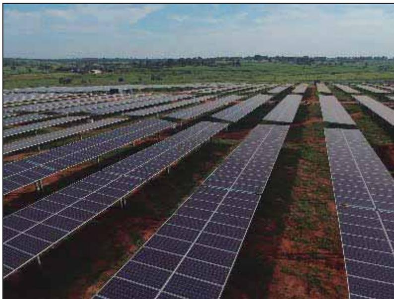
Imagen 6: Detalle seguidor SP-160
