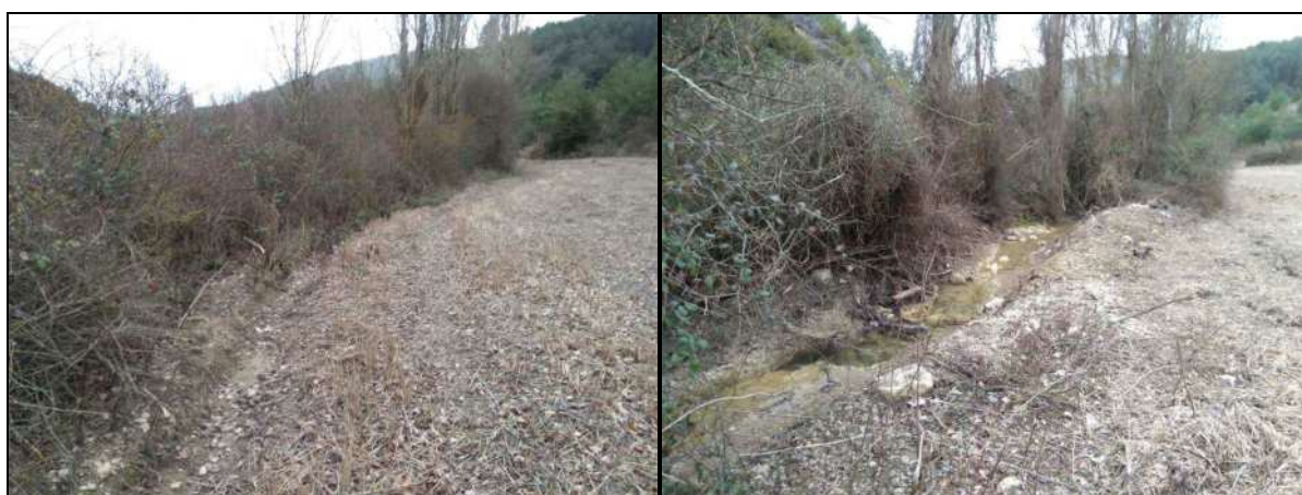
El desbordamiento de la regata en avenidas ordinarias generará daño en el margen al igual que en la 209.
