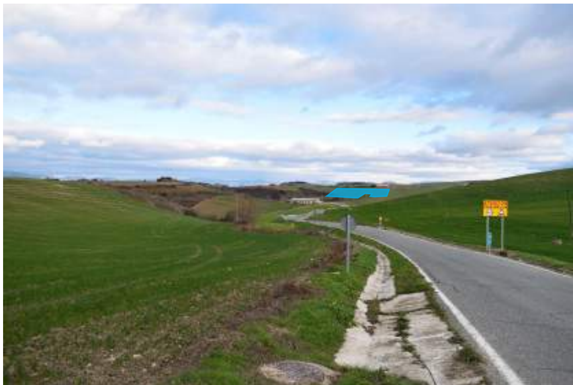
Figura 42: Representación de la PFV sobre fotografía sacada desde el ZCPO 11 en dirección Este.
