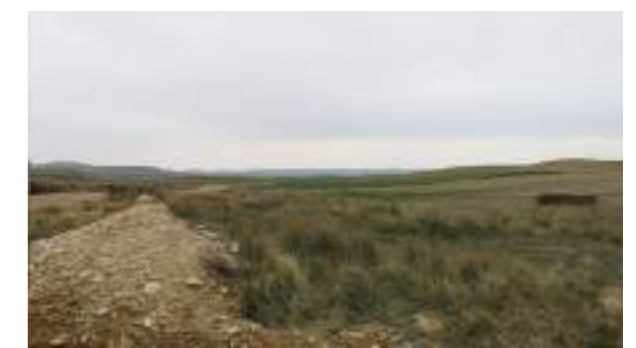
PSFV LA PINTA 7, 4,99 MW Miranda de Arga (Navarra)
