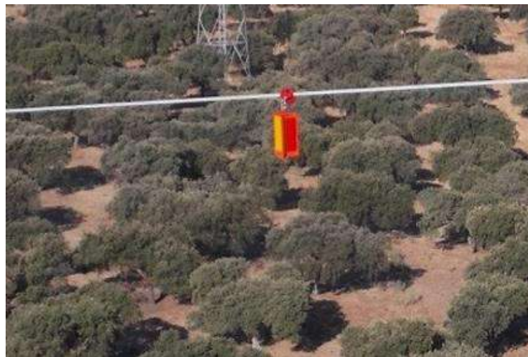
Foto 1. Vista del dispositivo instalado en el cable de tierra
