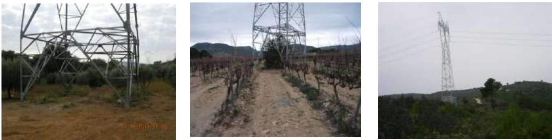
Foto 3. Situación final. Fuente: Red Eléctrica.
