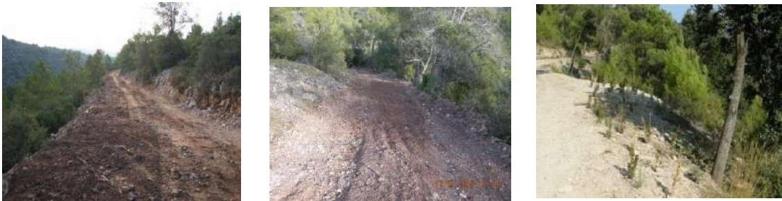
Foto 4. Situación final. Fuente: Red Eléctrica.
