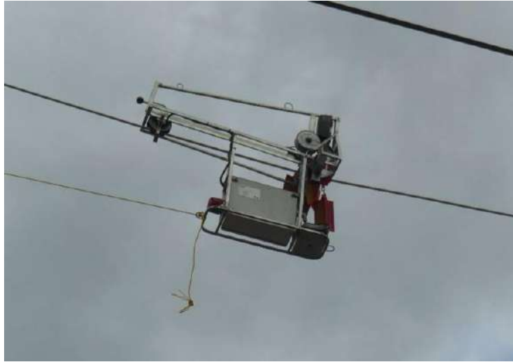
Foto 2. Vista de la máquina semiautomática de instalación.
