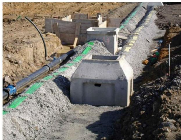
\* Se colocarán arquetas registrables en la entrada al CT y CS así como en los cambios de dirección del trazado de la nueva LSMT de 13,2 kV.
