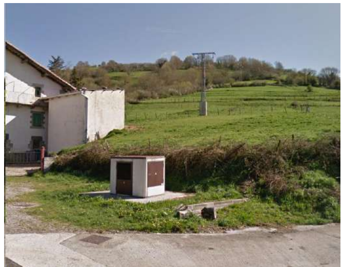
C.T. UITZI (901201940) a desmontar y apoyo Nº25.30
