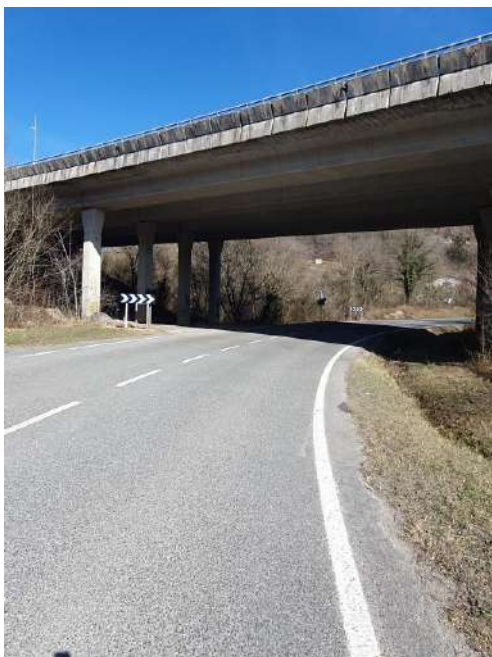
Cruzamiento Puente A-15 P.K. 127+320
