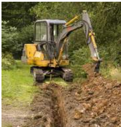
Imagen 15. Excavación de zanjas
