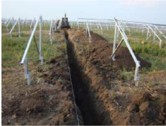
Imagen 17. Tendido de cable en zanja
