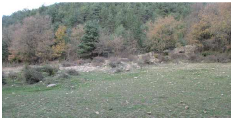
Imagen 18: Parcela 214, desprendimiento vista sur
