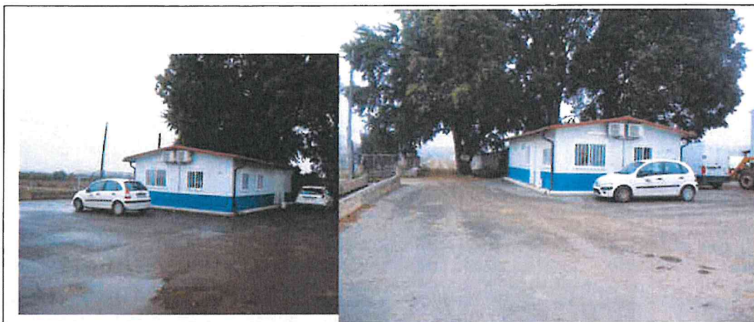
Cuadro nº 12. Nuevas instalaciones.
