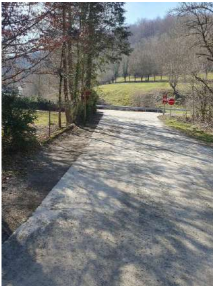
Inicio afección tramo N° 1 al monte N° 550.
