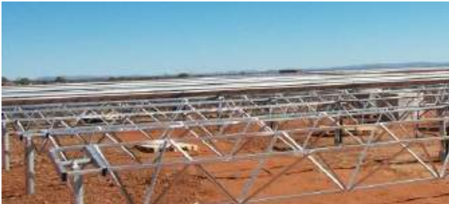
Imagen 16. Montaje de estructura solar con perfiles hincados directamente en el terreno
