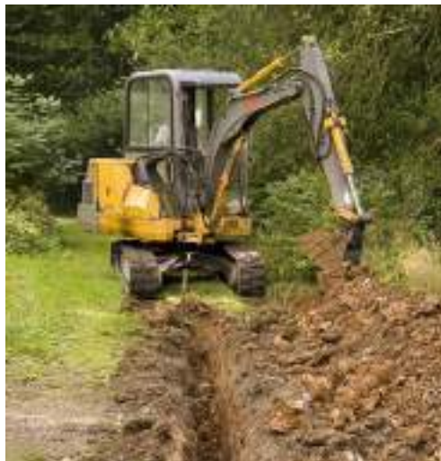
Imagen 15. Excavación de zanjas
