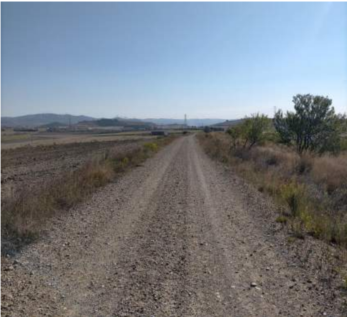
Camino de acceso que conecta las posiciones de la alineación SA_05 a SA_09
