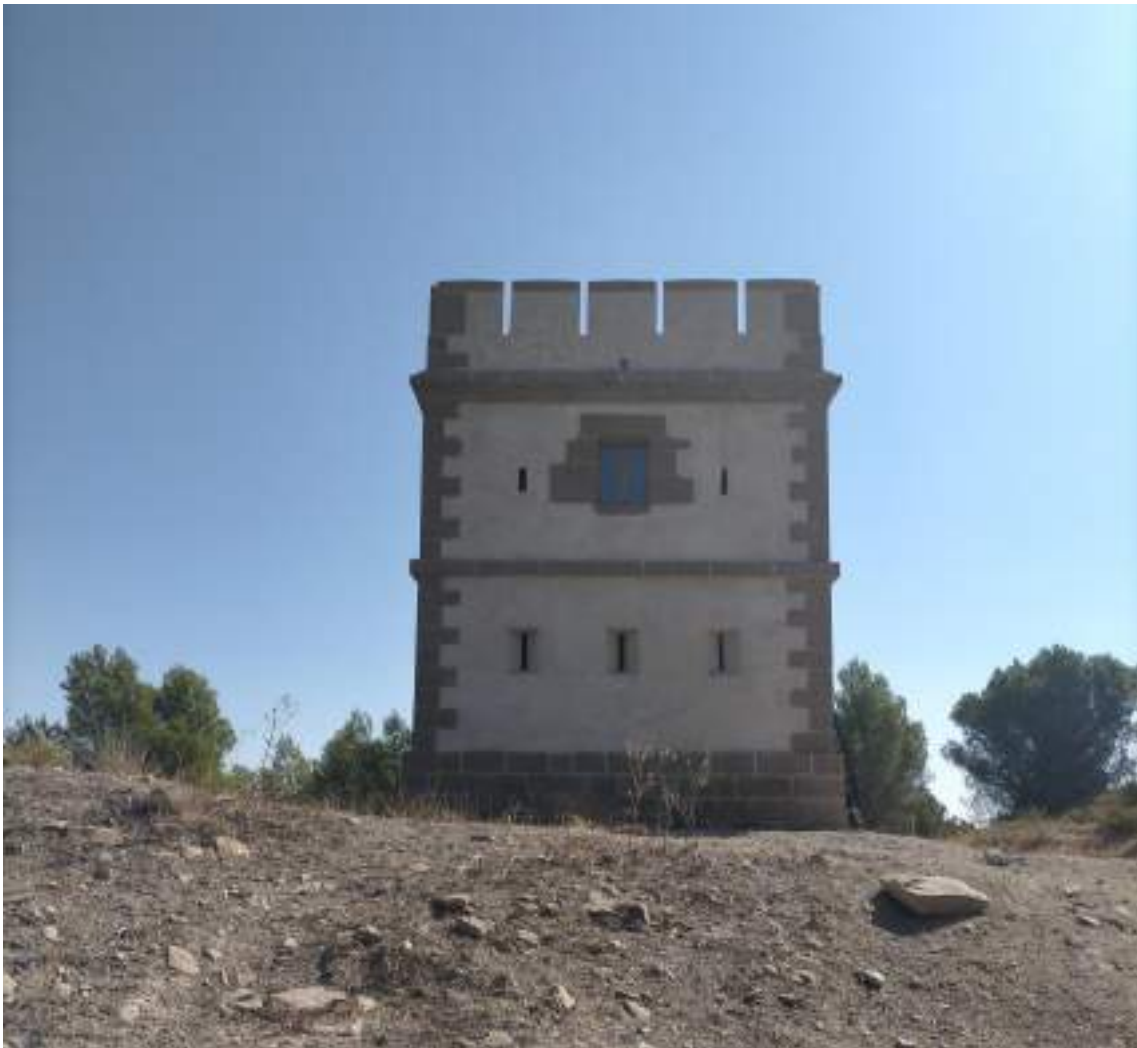
Torre Beratxa al este del aerogenerador proyectado SA_02
