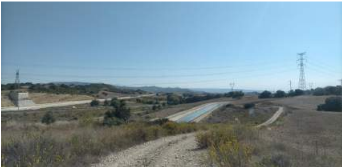
Al fono punto por el que se cruzará la línea de evacuación eléctrica con la línea eléctrica existente y con el Canal de Navarra.
