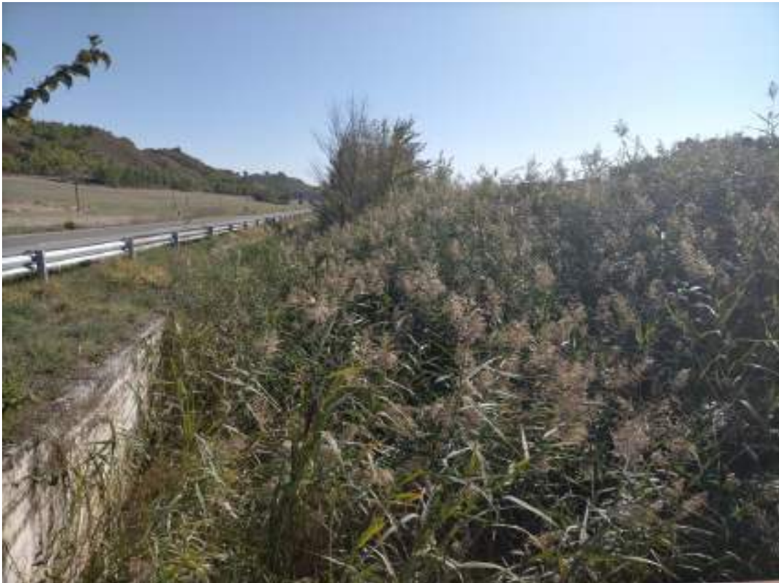
Vegetación halófila presente en el Barranco Valdiferrer junto a carretera NA - 132
