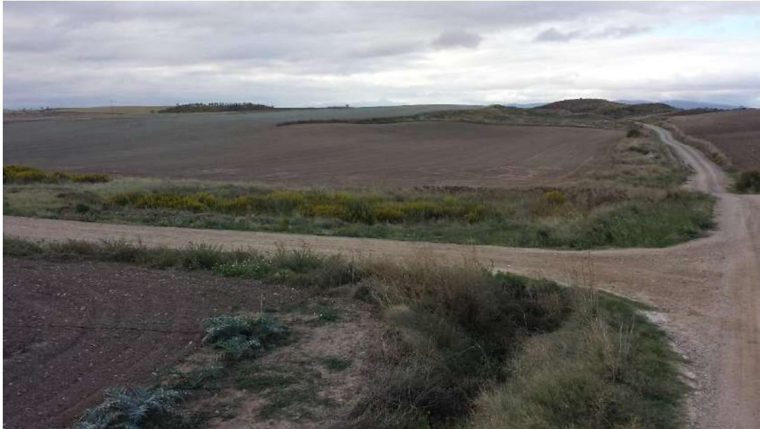
Foto 3. La P-15 corre paralela al camino que se pierde en el horizonte, por el lado derecho. La CDPPE viene de la izquierda de la imagen, por detrás del camino. La zanja de la conducción que se dirige a la SET cruza este camino y discurre paralela al camino que sigue de frente, por su lado izquierdo.
