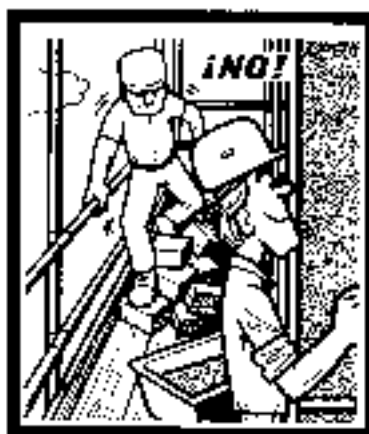
Almacena los materiales correctamente para evitar todos los riesgos de accidentes derivados al paso de los trabajadores.
