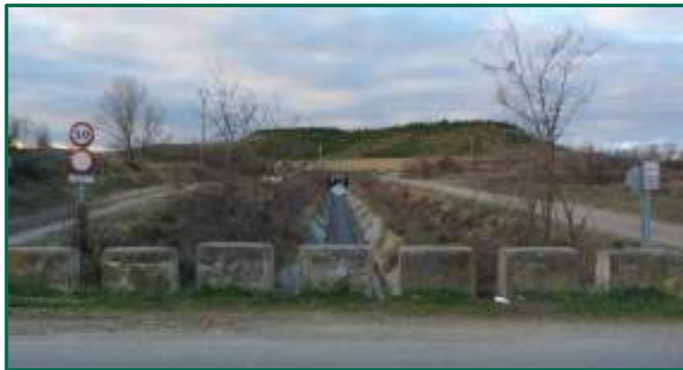
Fotografía 1. Detalle del desagüe del Canal de Lodosa próximo al parque eólico.
