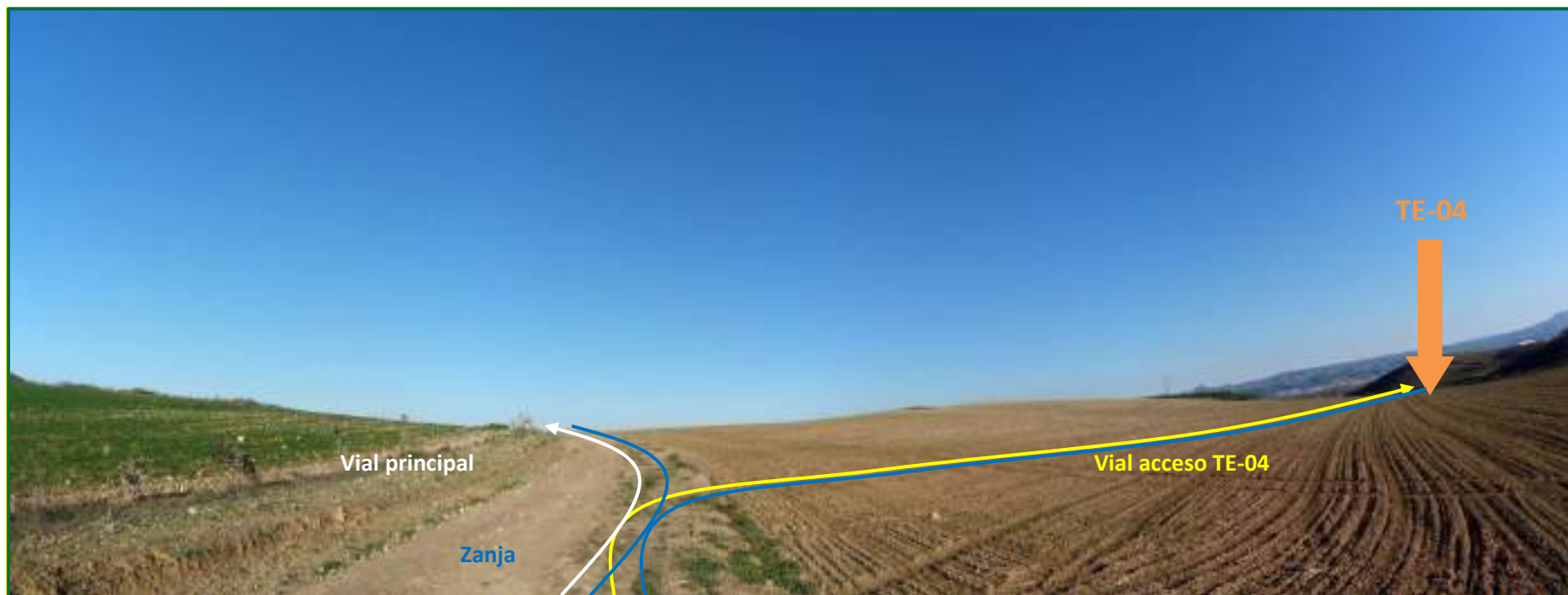
Fotografía 16. Acceso aerogenerador TE-04 y zanja.
