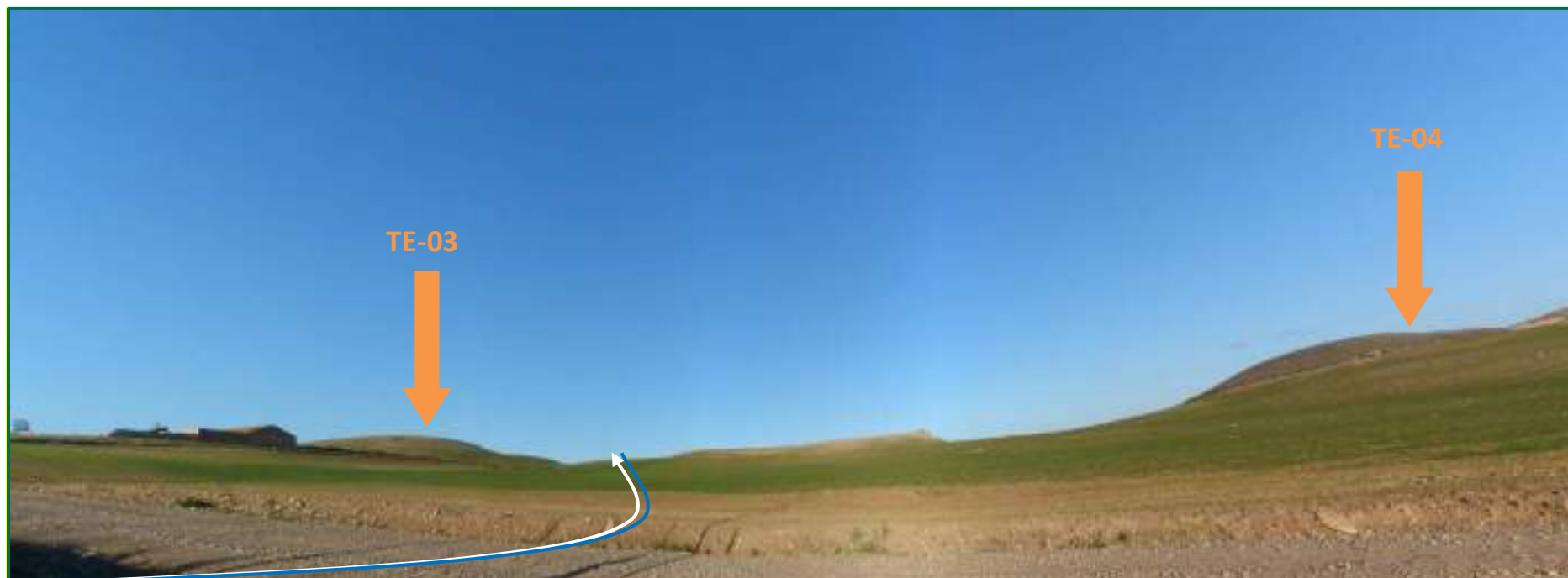
Fotografía 12. Vial de acceso en dirección a los Aerogeneradores TE-03 y TE-04 y zanja.
