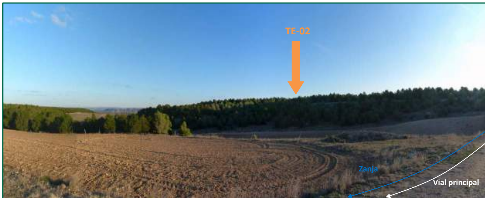
Fotografía 9. Ubicación del Aerogenerador TE-02, visto desde el noroeste.
