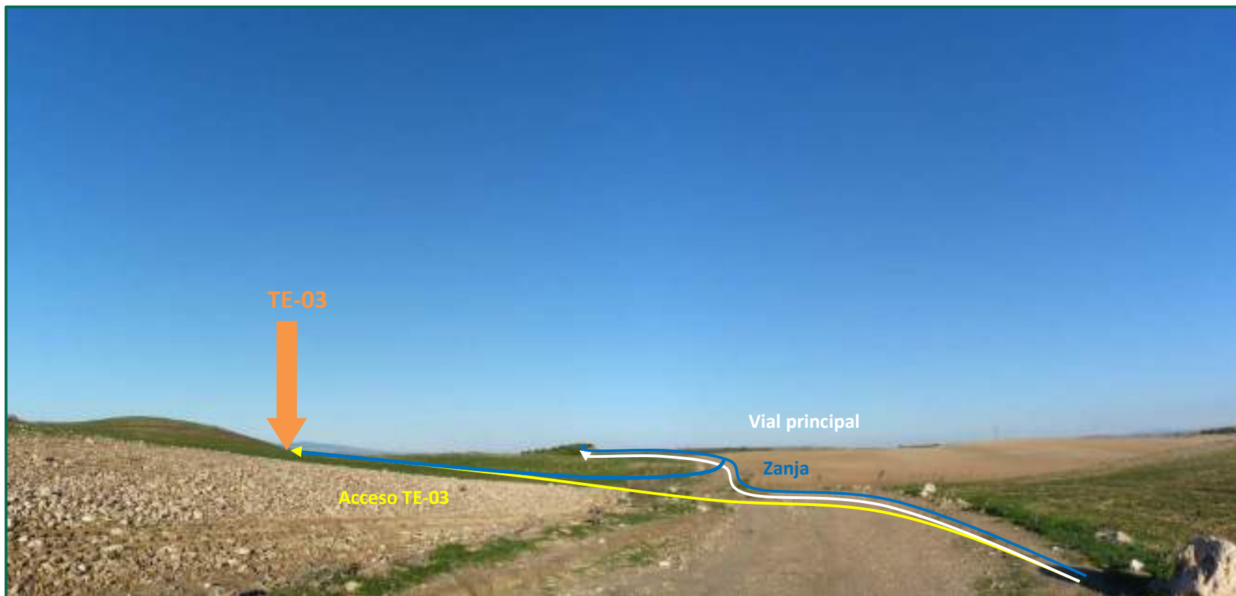
Fotografía 15. Acceso aerogenerador TE-03.
