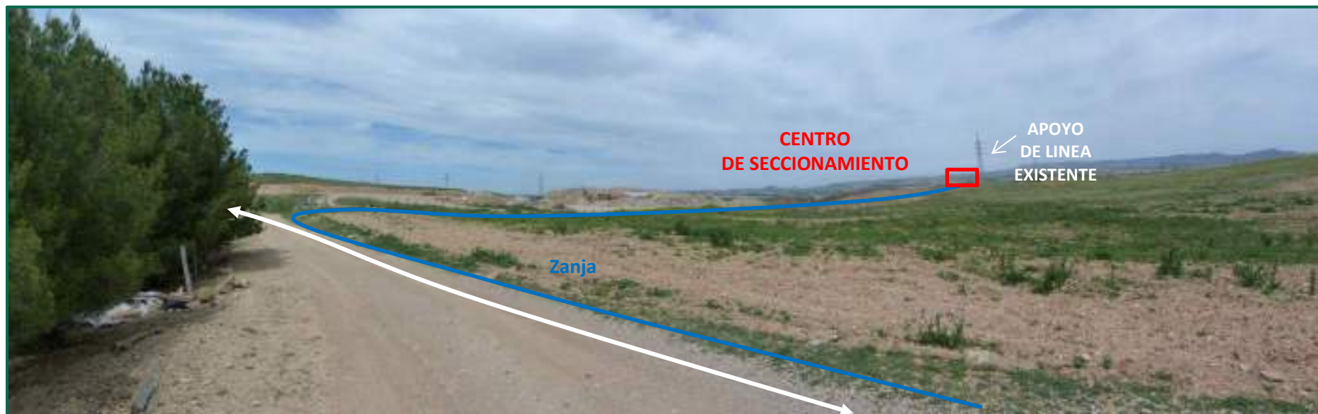
Fotografía 21. Línea soterrada en dirección al Centro de Seccionamiento.
