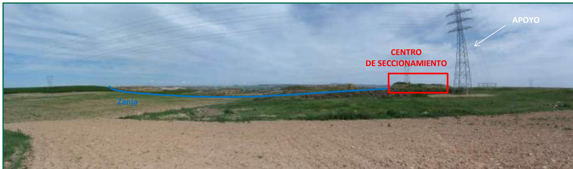
Fotografía 23. Centro de entrega del parque eólico y apoyo de línea eléctrica existente donde evacúa la energía.
