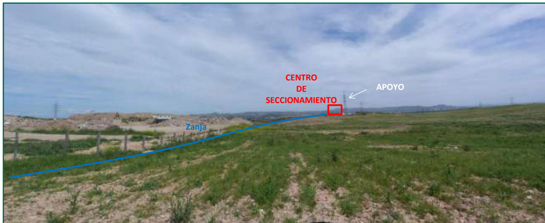
Fotografía 22. Zanja para línea soterrada en dirección al centro de seccionamiento ubicado junto a la línea existente donde evacúa.
