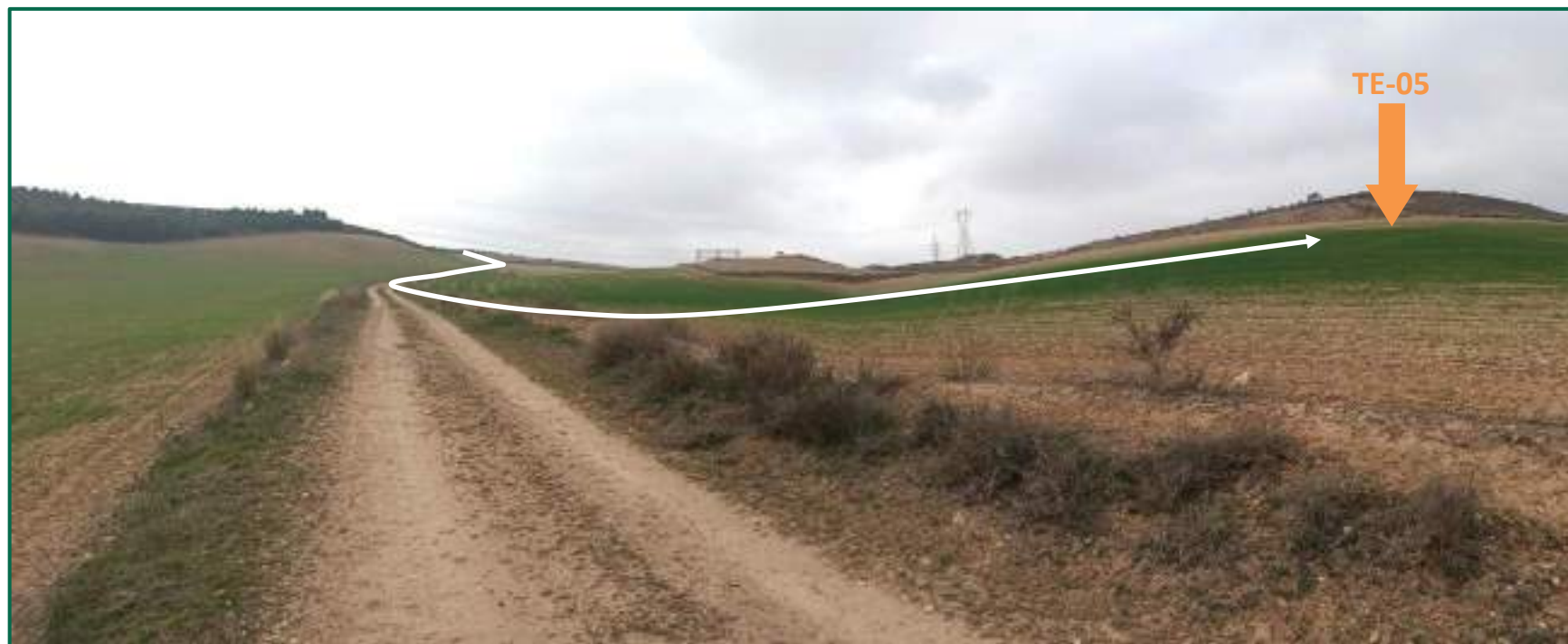
Fotografía 19. Vial de acceso al aerogenerador TE-05.
