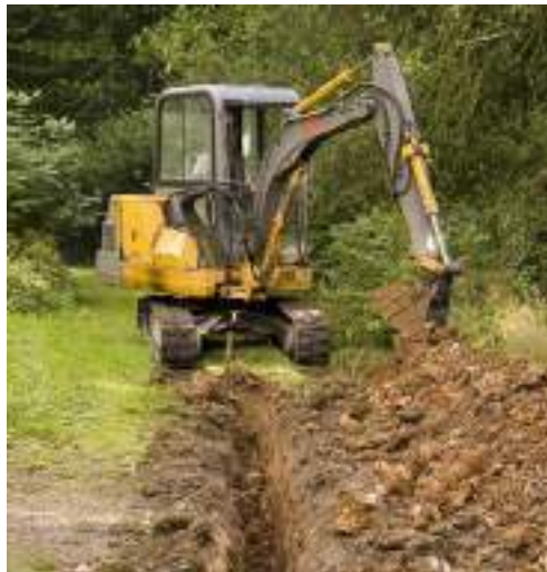
Imagen 15. Excavación de zanjas
