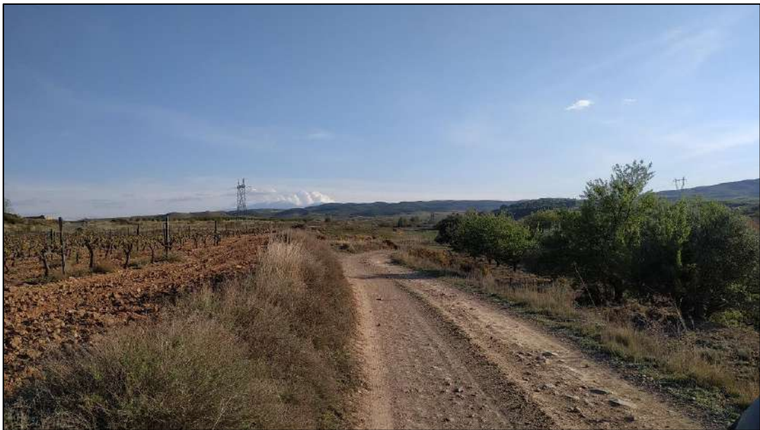
Vista del trazado por el que transcurrirá la línea aérea de evacuación.
