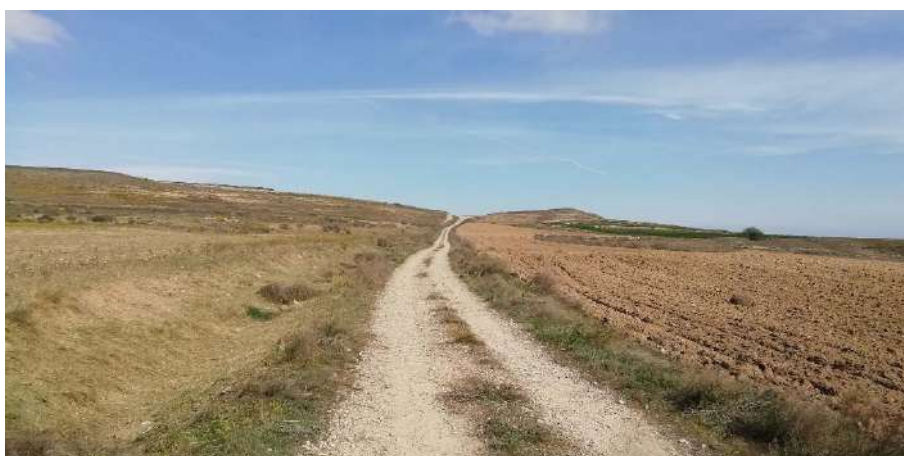
Imagen 8. Parte central de la línea soterrada.
