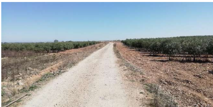
Imagen 73. Acceso a CH06.
