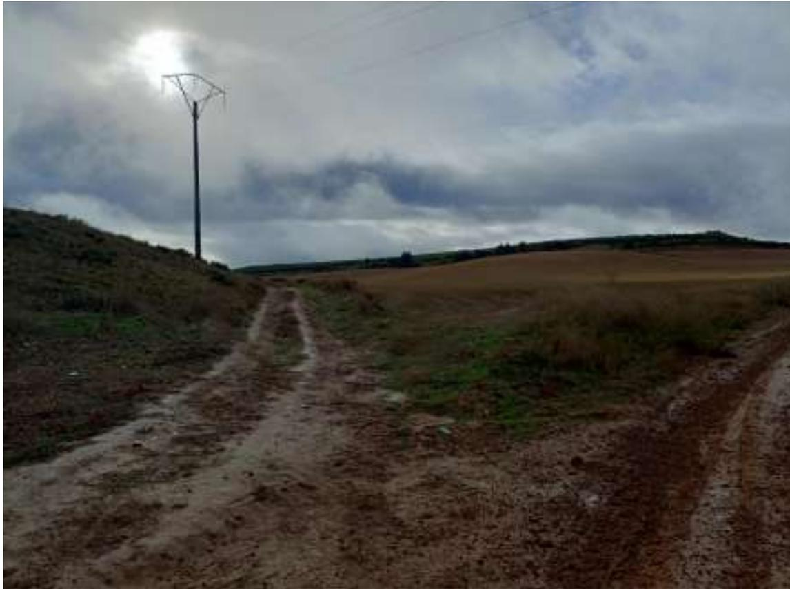
**Foto 13.** Detalle del camino rural a acondicionar para el vial de acceso a OLI03. El vial toma el camino de la izquierda, por la derecha del apoyo del tendido. El tendido que se ve es LAT 66kV Renfe-Alcanadre, a donde se evacúa la energía del P.E. Dicho apoyo será retirado y sustituido por otro próximo, para facilitar la conexión desde SET Oliado.
