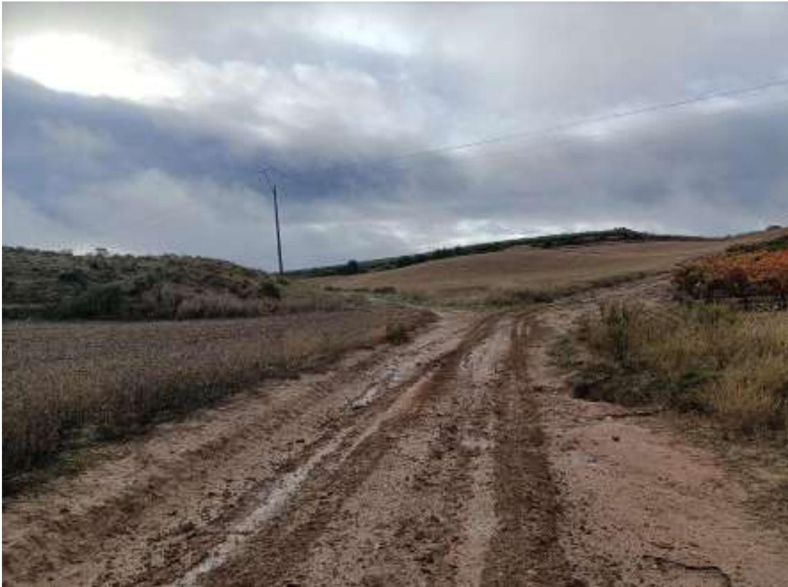
**Foto 12.** Camino rural a acondicionar para el vial de acceso a OLI03. El vial gira a la izquierda, por detrás del apoyo del tendido. El tendido que se ve es LAT 66kV Renfe-Alcanadre, a donde se evacúa la energía del P.E.
