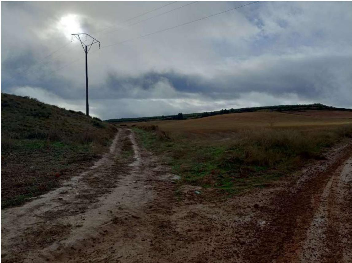
**Foto 14.** Detalle del camino rural a acondicionar para el vial de acceso a la SET. El vial toma el camino de la izquierda, por la derecha del apoyo del tendido. El tendido que se ve es LAT 66kV Renfe-Alcanadre, a donde se evacúa la energía del P.E. Dicho apoyo será retirado y sustituido por otro próximo, para facilitar la conexión desde SET Oliado.
