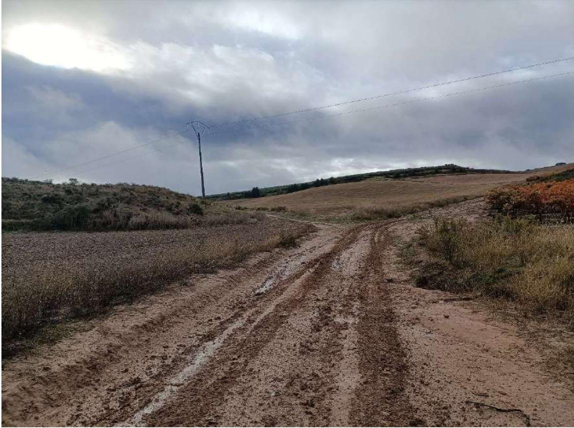
**Foto 13.** Camino rural a acondicionar para el vial de acceso a la SET. El vial gira a la izquierda, por detrás del apoyo del tendido. El tendido que se ve es LAT 66kV Renfe-Alcanadre, a donde se evacúa la energía del P.E.
