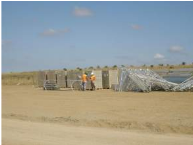
Imagen 8. Fotografía de instalaciones provisionales
