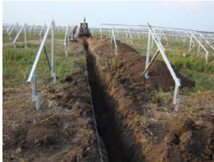
Imagen 17. Tendido de cable en zanja
