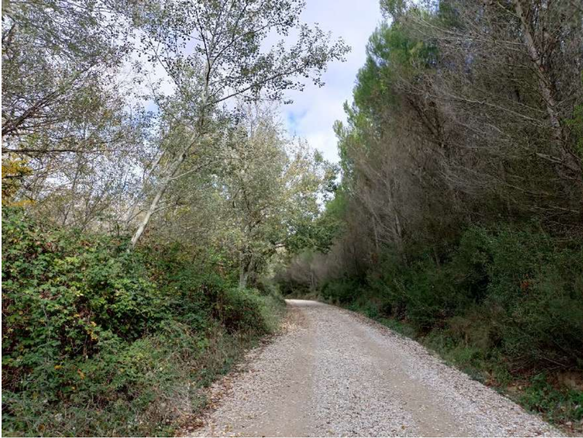
Foto 7. Vista del vial de acceso a LOB01 y LOB02. Es necesario realizar un desmonte en la ladera de la derecha. A la derecha, repoblación de pino carrasco con romeral; a la izquierda, plantación de álamos con zarzal.
