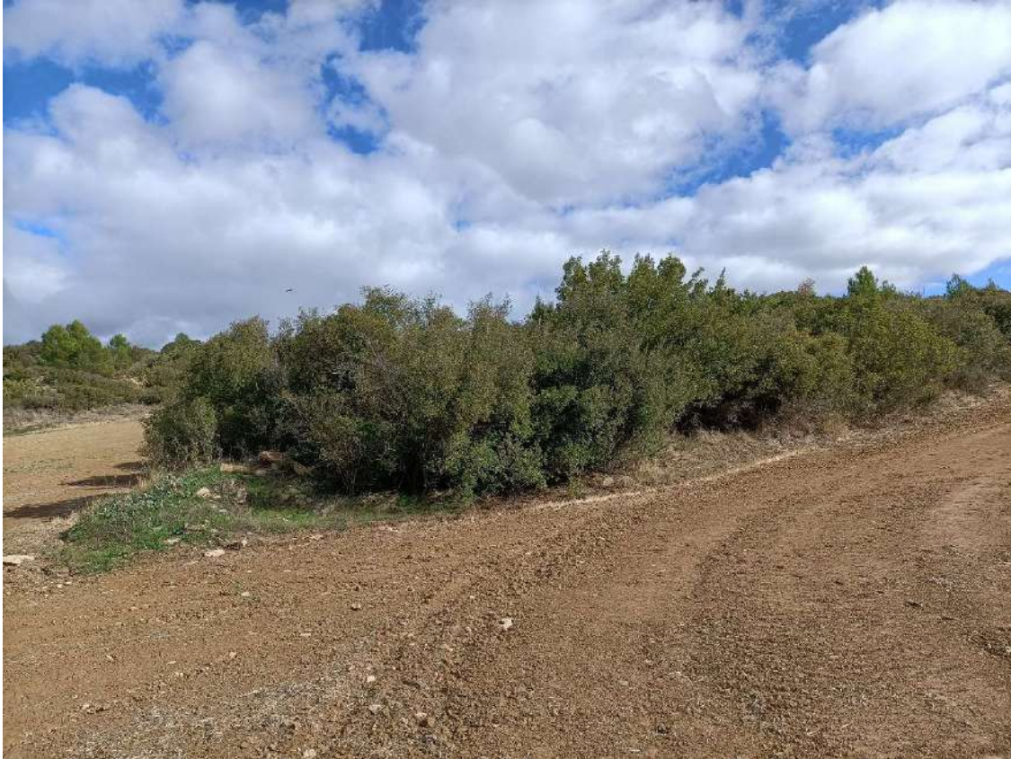
Foto 19. Posición LOB04. Detalle del matorral (coscojar y romeral-ollagar) afectado por la plataforma de montaje.
