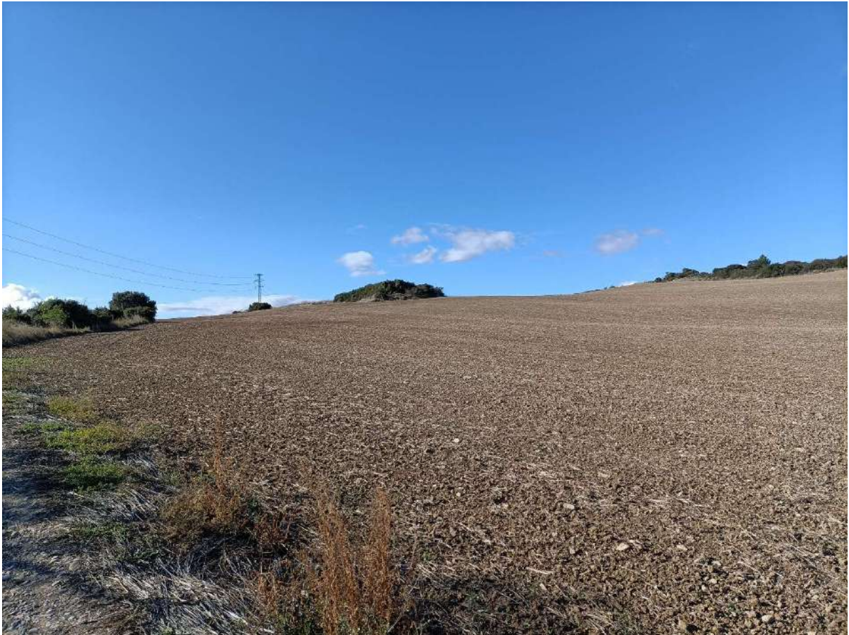
Foto 22. Parcela sobre la que situará la subestación 20/66kV-SET Lobera
