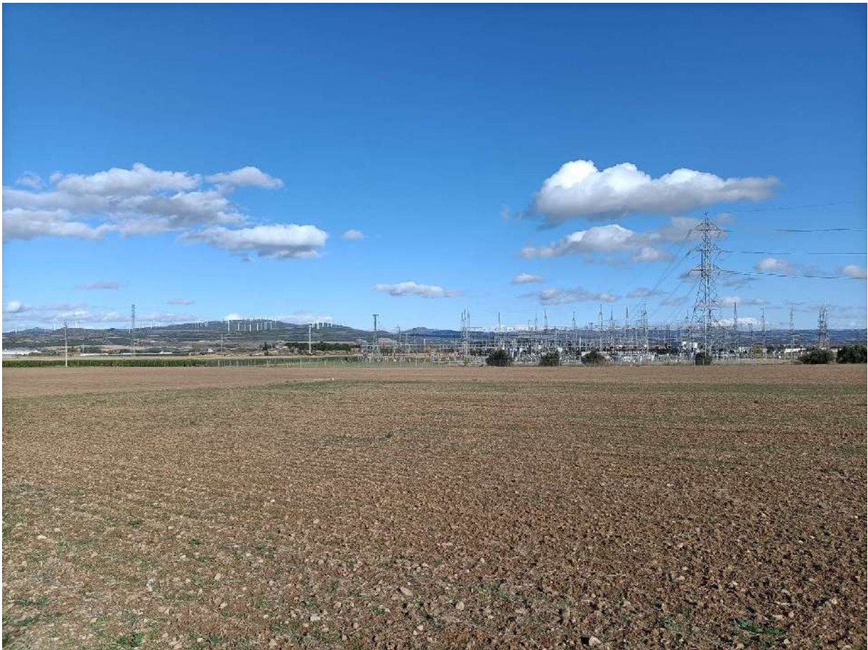
Foto 23. Parcela sobre la que situará la subestación 66/220kV-SET Promotores
