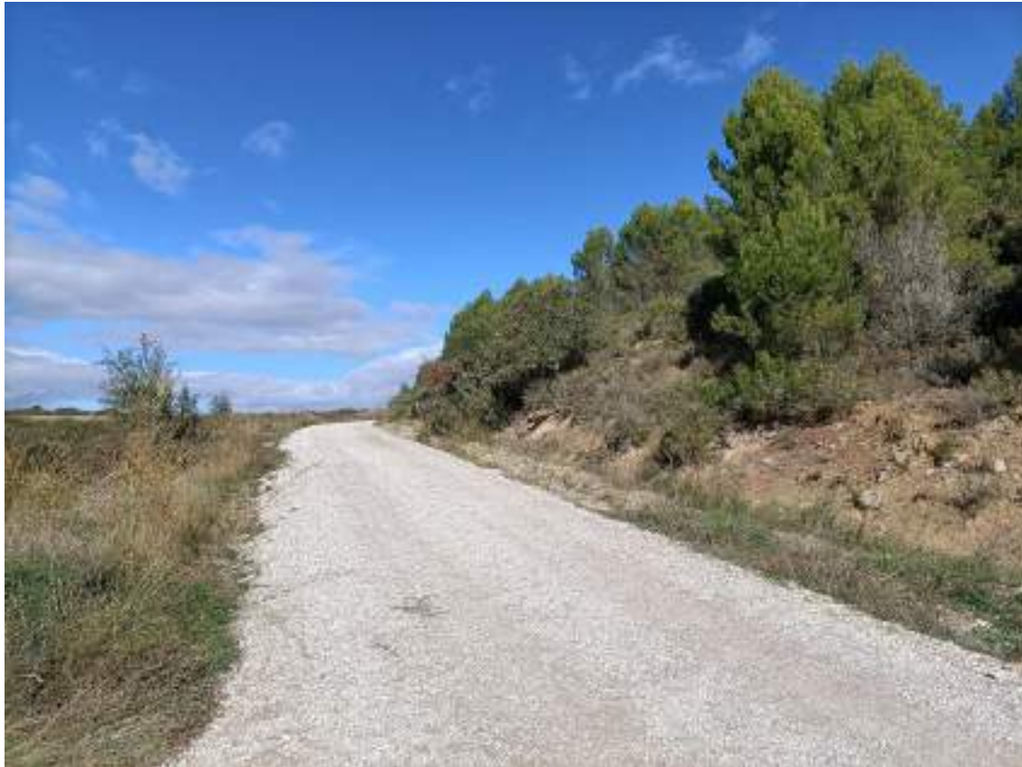
Foto 3. Vista del camino rural a acondicionar para el acceso. En este punto es necesario realizar un desmonte en el lado derecho. La vegetación es un romeral ollagar con algunas coscojas, así como unos pequeños pinos de una repoblación.
