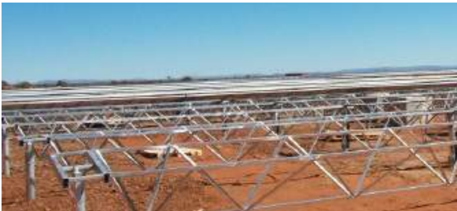
Imagen 16. Montaje de estructura solar con perfiles hincados directamente en el terreno
