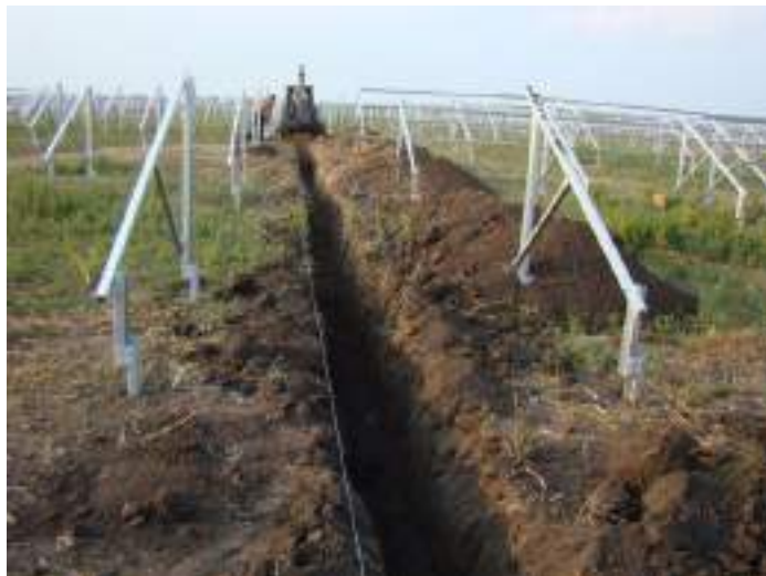
Imagen 17. Tendido de cable en zanja
