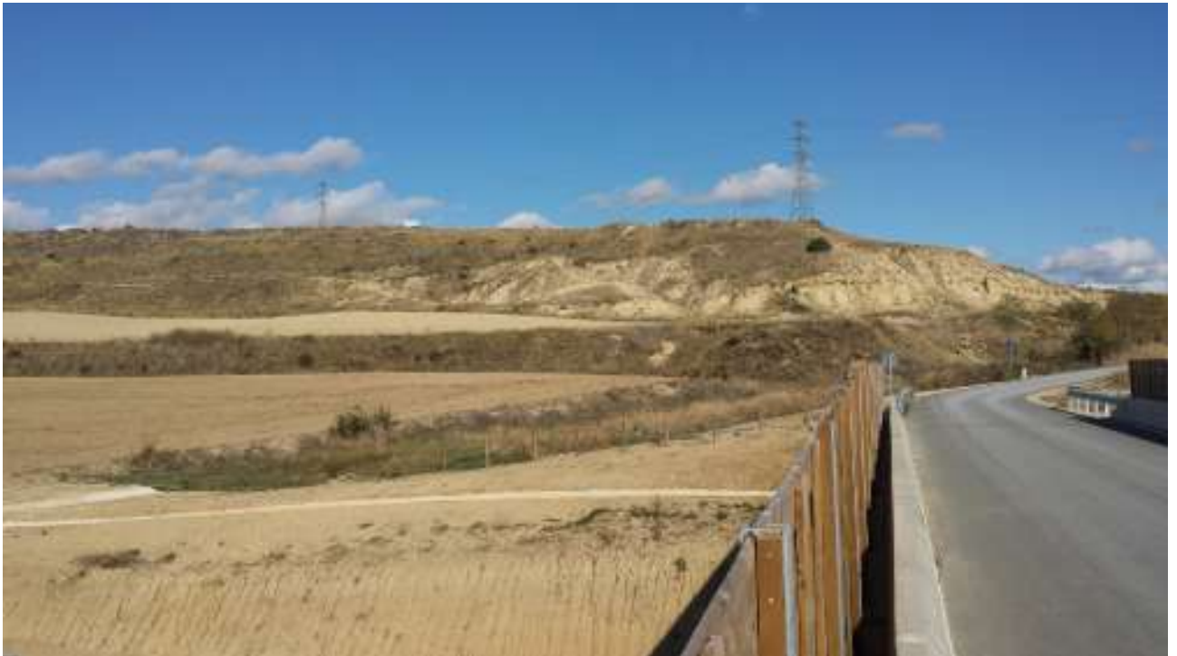
Puente sobre la variante de Tafalla, por el que discurre actualmente la cañada T-9. El apoyo nº 15 de la LAT 66kV se situaría en los campos a la izquierda de la imagen, fuera de cuadro.
