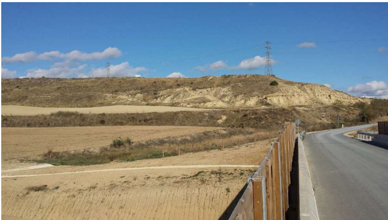
Puente sobre la variante de Tafalla, por el que discurre actualmente la cañada T-9. El apoyo nº 15 de la LAT 66kV se situaría en los campos a la izquierda de la imagen, fuera de cuadro.
