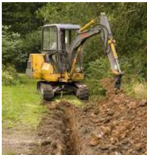
Imagen 15. Excavación de zanjas
