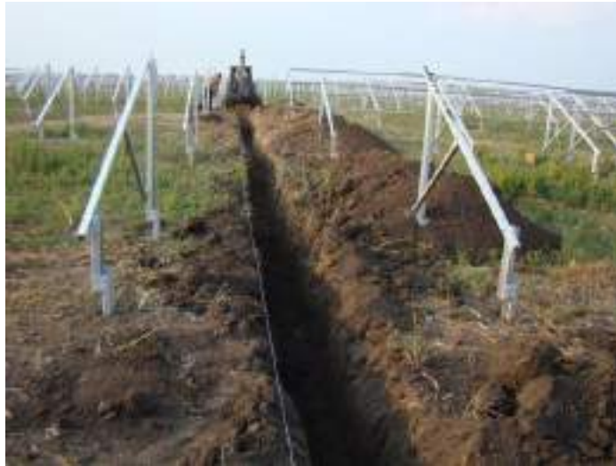
Imagen 17. Tendido de cable en zanja
