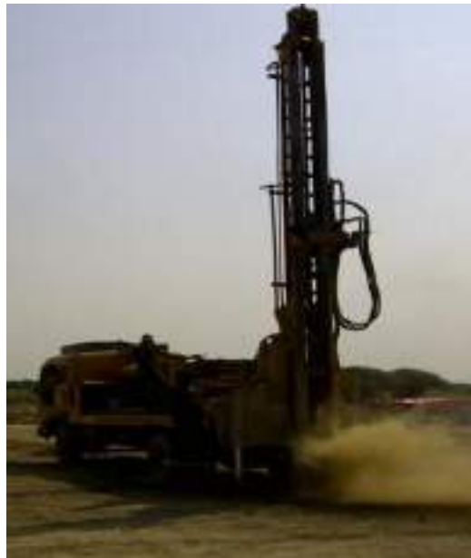
Imagen 14. Hincado de perfiles con maquinaria especializada
