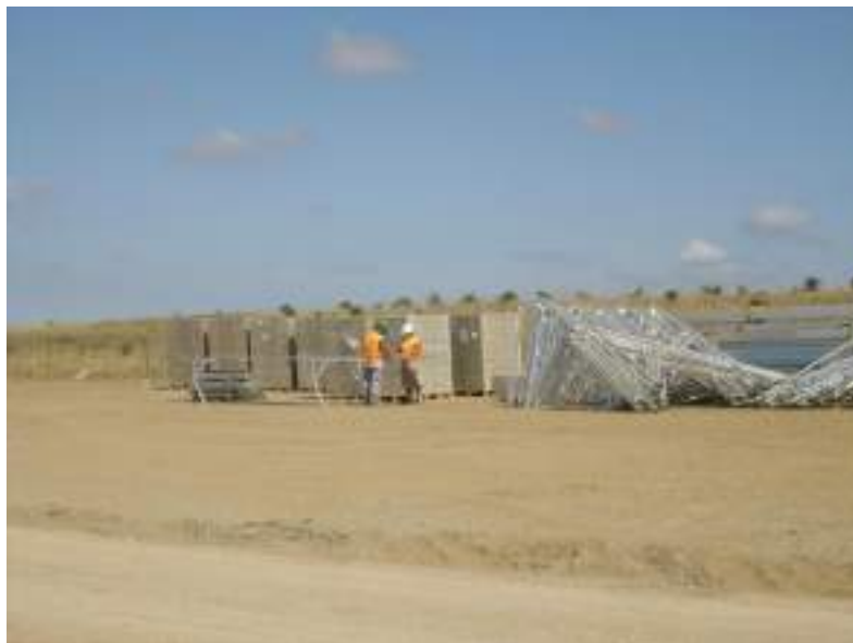
Imagen 8. Fotografía de instalaciones provisionales
